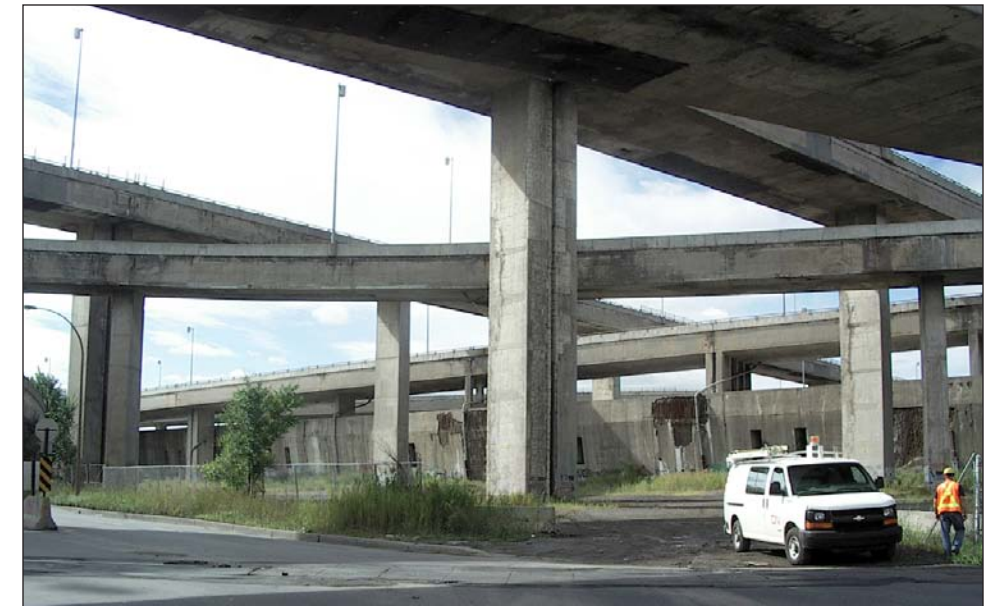
Dessous de l'infrastructure vue de la rue Notre-Dame
