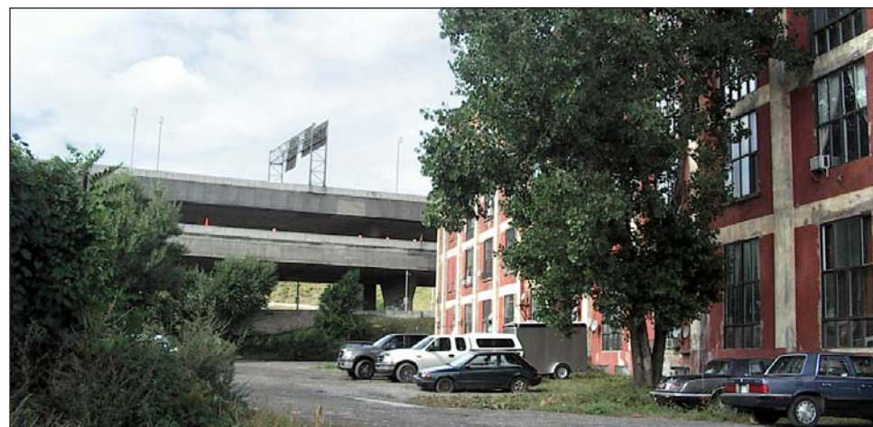
Bâtiment résidentiel, 780 rue Saint-Rémi
