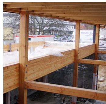
*Illustration 12: Assemblage des poutres primaires sur les poteaux*
