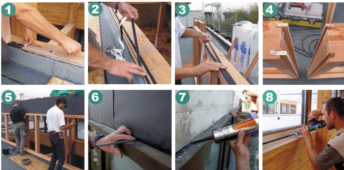
Illustration 31: Processus de mise en œuvre des menuiseries
