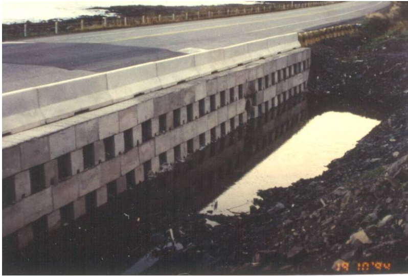
Fosse de captage en blocs de béton ajourés. Route 132, La Martre à Marsoui.
