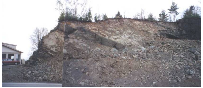
Rupture en escalier (Rte 132, St-Nicolas)
