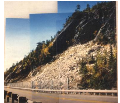
Clôture de captage, Lac du Séminaire, Rte 138, Baie des Rochers.
