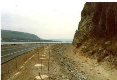
Fosse de captage réalisée à l'aide d'un remblai, Route 155, Grandes- Piles, Mauricie
