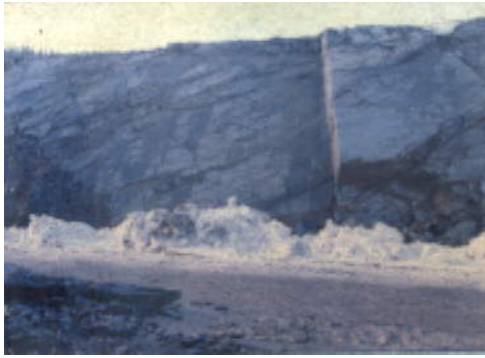
Exemple de rupture planaire simple (Rte 132, Vallée de la Matapédia)
