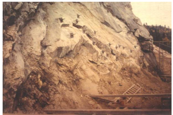
Ancrages passifs, Route 138, Lac du Séminaire, Baie des Rocher, Charlevoix.
