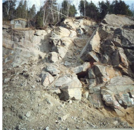
Même endroit après excavation par forage et sautage
