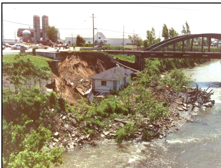
Figure 4 : Croquis et photo d'un glissement rotationnel
