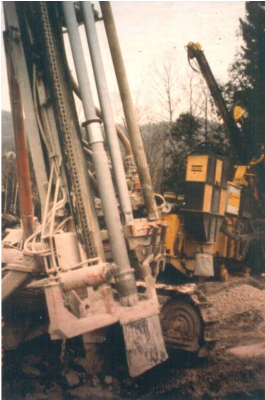
Foreuse à marteau fond de trou.
