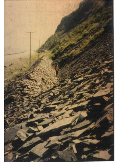
Fosse de captage réalisée à même les matériaux d'éboulis. Route 132, Gros-Morne à Manche d'Épée.
