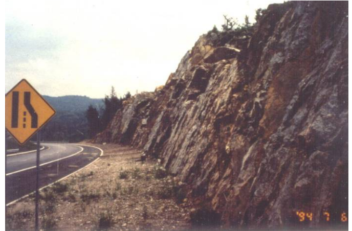
Prédécoupage selon une pente 2H :5V à l'aide d'une foreuse à marteau fond de trou. Autoroute 5, contournement de Wakefield.
