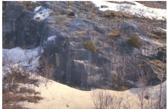
Treillis métallique mis en place le long du boulevard Champlain, Québec.
