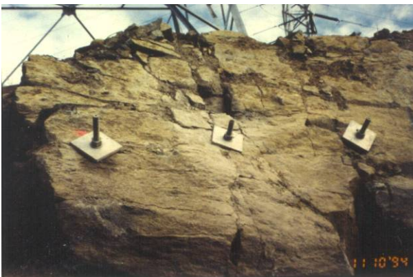
Ancrages actifs, Route 169, Parc des Laurentides.
