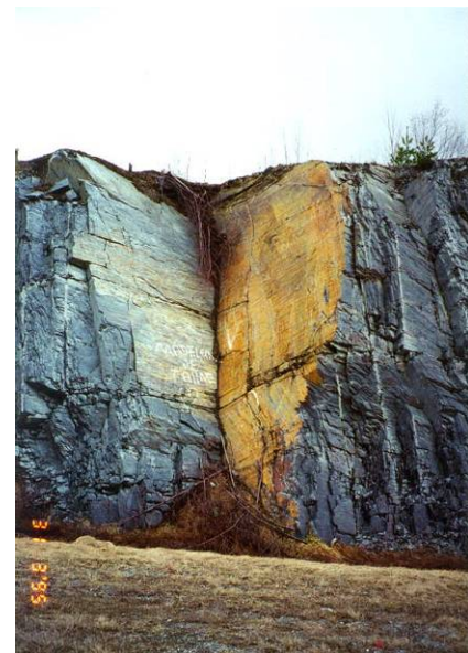
Exemple d'une rupture en dièdre (Autoroute 10, Sherbrooke)
