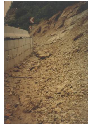
Fosse de captage réalisée avec des blocs en béton. Route 132, Pic de l'Aurore, Gaspésie
