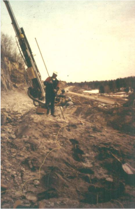
La mise en position de la foreuse est une étape cruciale sur la qualité de l'orientation et l'inclinaison du trou de forage.
