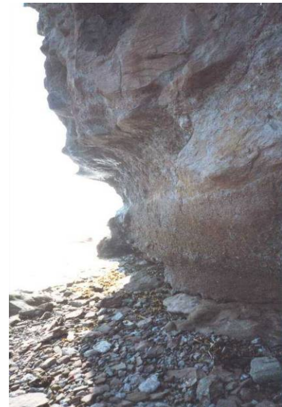
Exemple d'érosion de la base de falaise (Caplan, Baie des Chaleurs)
