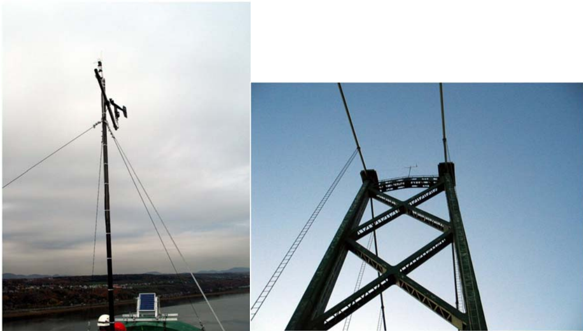
Figures 2 et 3 : Anémomètre installé au sommet de la tour sud du pont
