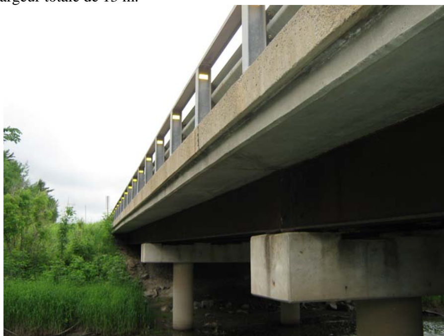
Fig. 1 : Photographie du pont sur la 317 à St-Sixte
