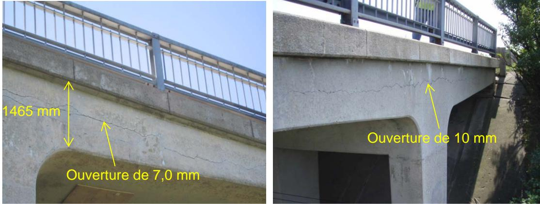
Photo 1 – Fissuration typique associée à la réaction alcalis-silice sur le côté extérieur d'un portique en béton armé sans armature de cisaillement
