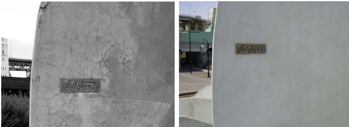
Fig.3 – Aspect de surface de la fontaine de La Ronde avant réparations (à gauche) et 7 ans après les travaux : aucun faïençage ni fissuration du mortier mince de finition n'est observé.
