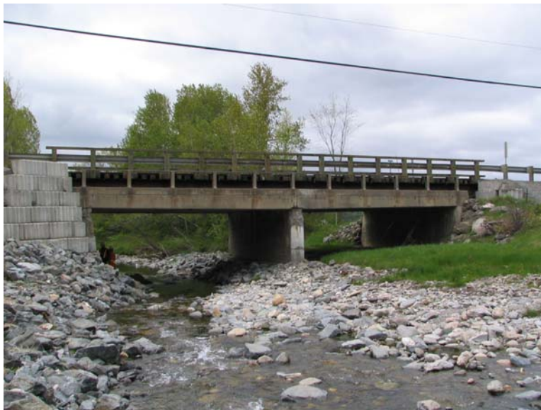
Figure 1 – Vue d'ensemble de l'ouvrage (Face amont)
