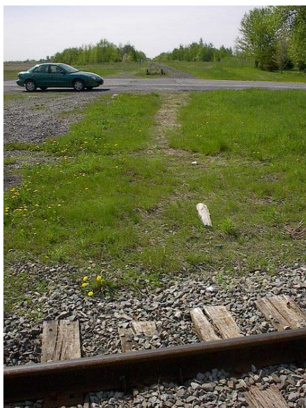
Photo 4.16 - Vue de l'emprise ferroviaire où se trouvait autrefois la connexion directe entre l'embranchement industriel Lacolle et la ligne vers East Alburg
