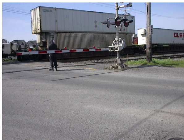
Photos 4.3 et 4.4 - Passage à niveau équipé de deux barrières, de feux et de cloches à l'entrée de la cour de triage Southwark
