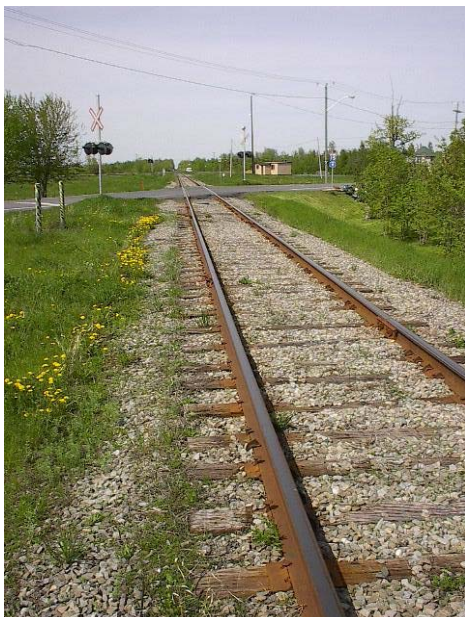
Photo 4.18 - Vue vers le nord de la ligne Rouses Point à Saint-Jean-sur-Richelieu
