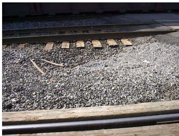
Photo 4.2 - Traverses danseuses à la sortie d'un passage à niveau.
