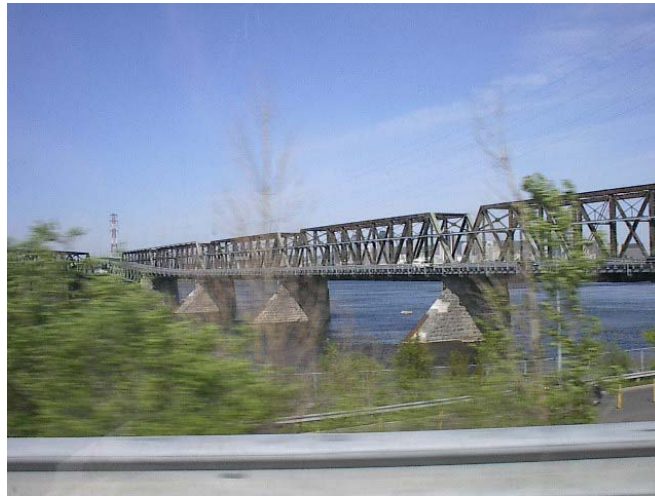
Photo 4.5 - Pont Victoria, vue de Saint-Lambert vers Montréal
