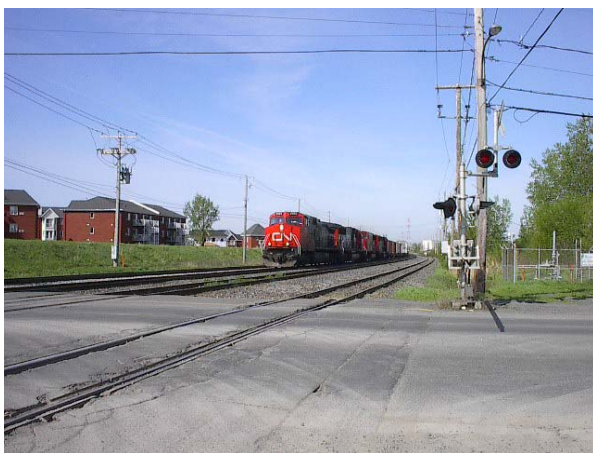
Photos 4.3 et 4.4 - Passage à niveau équipé de deux barrières, de feux et de cloches à l'entrée de la cour de triage Southwark
