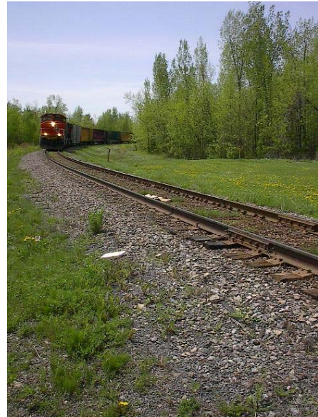
Photo 4.9 - Courbe au niveau de Castel Gardens pour l'embranchement vers Rouses Point. La voie en alignement continue vers Chambly, puis Marieville
