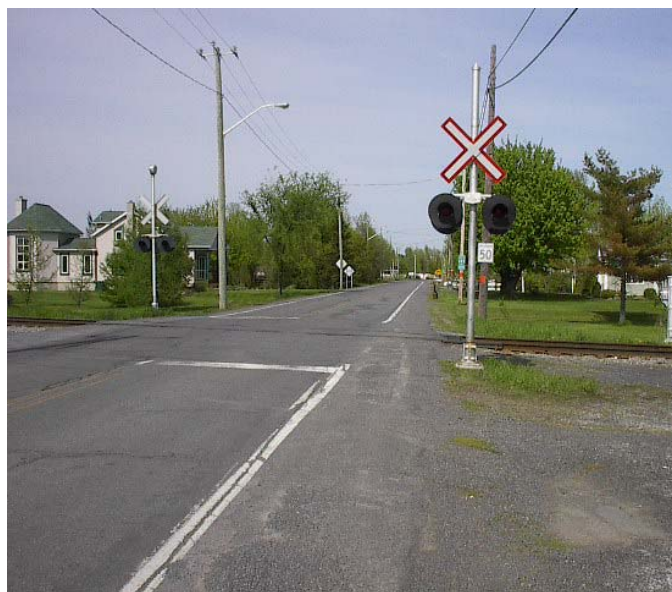
Photo 4.17 - Passage à niveau du raccordement (en courbe) entre les lignes du CN reliant Saint-Jean-sur-Richelieu à East Alburg
