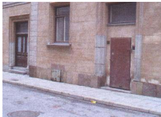
Espace technique de stockage
