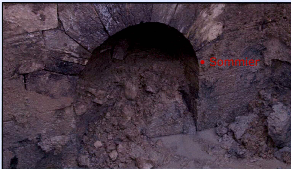
Figure 39 : L'arc de l'entrée de l'aqueduc n° 3 (localisée au sud du canal). Patrimoine Experts S.E.N.C., novembre 2008.
