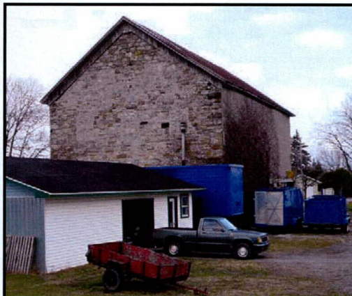
Figure 46 : Bâtiment près de l'écluse n° 9 (la première écluse), au sud de celle-ci ; construit avant 1852. Bergeron Gagnon inc.
