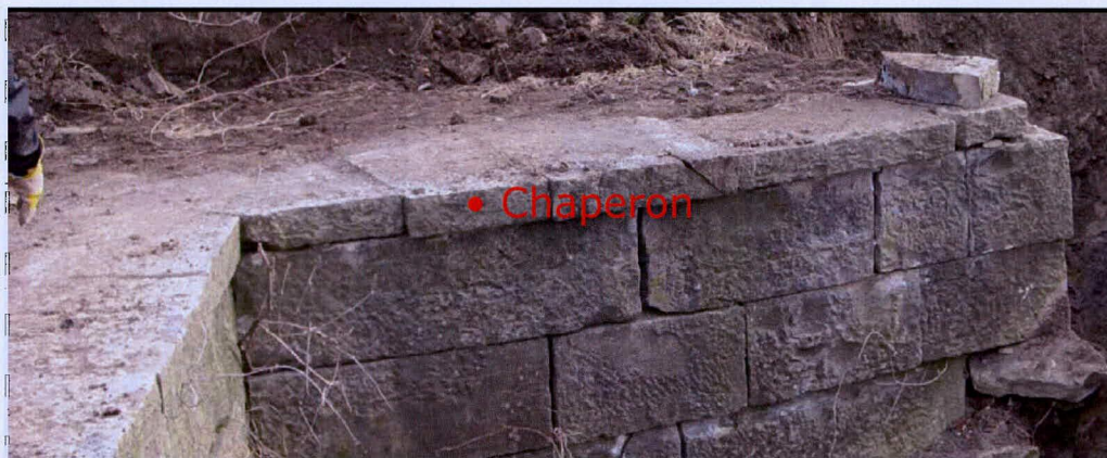
Figure 42 : Le chaperon de l'entrée de l'aqueduc n° 3. Patrimoine Experts S.E.N.C., novembre 2008.
