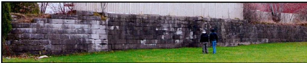
Figure 15 : Le bajoyer en pierre de taille dans le secteur Melochville de Beauharnois. À noter la présence d'une chambre latérale. Bergeron Gagnon inc.
