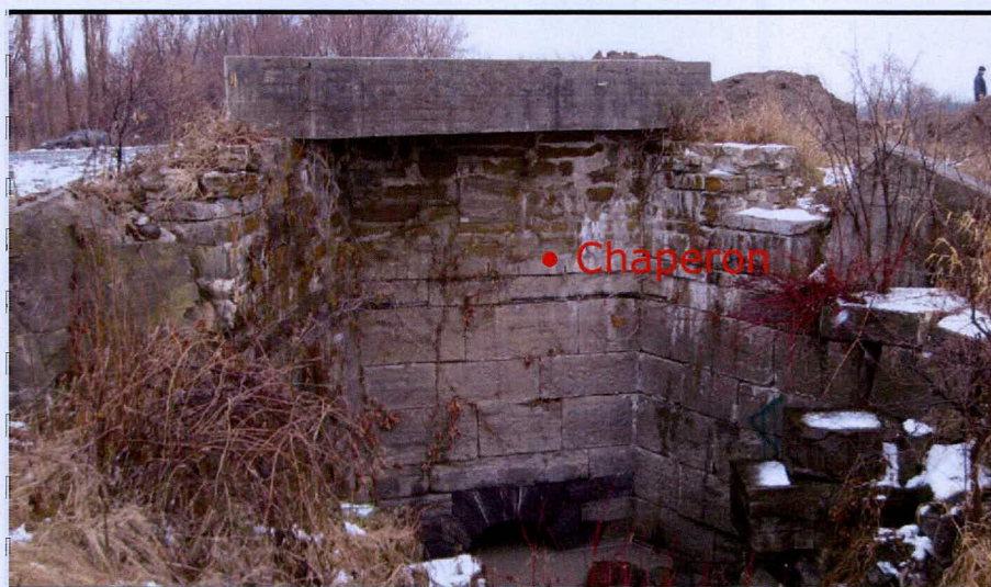
Figure 36 : L'assise la plus étroite se situe sous le chaperon de l'entrée de l'aqueduc n° 1 (localisée au sud du canal). Patrimoine Experts S.E.N.C., novembre 2008.
