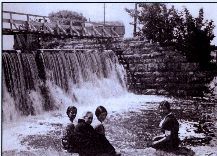
Figure 9 : Déversoir de l'une des écluses (Julien 1986 : 75).
