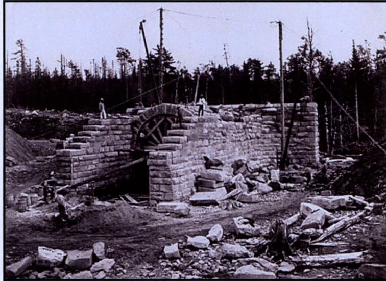
Figure 38 : Exemple de support en bois utilisé pour former la voûte lors de la construction d'un aqueduc ou d'un pont « Building a Culvert Under the Intercolonial Railway, Black River, Nova Scotia, 1871 ». Archives du Canadien National.
