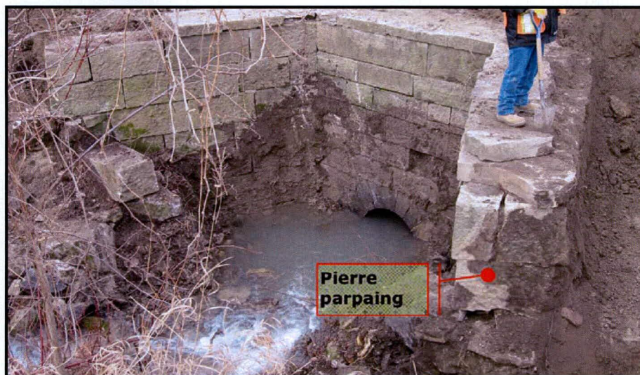
Figure 35 : Appareillage de pierre à l'entrée de l'aqueduc n° 3 (localisée au sud du canal). Exemple d'une pierre posée en parpaing. Patrimoine Experts S.E.N.C., novembre 2008.
