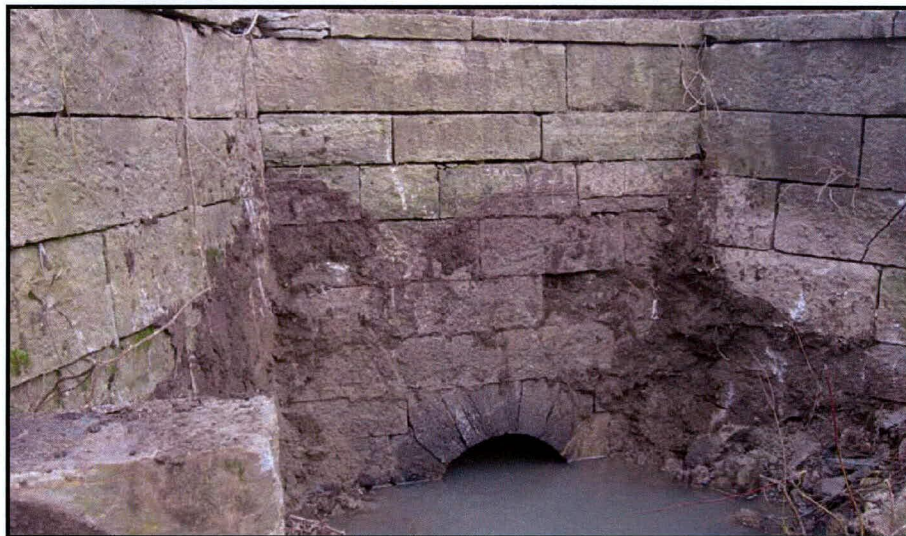
Figure 34 : Appareillage de pierre à l'entrée de l'aqueduc n° 3 (localisée au sud du canal). Patrimoine Experts S.E.N.C., novembre 2008.
