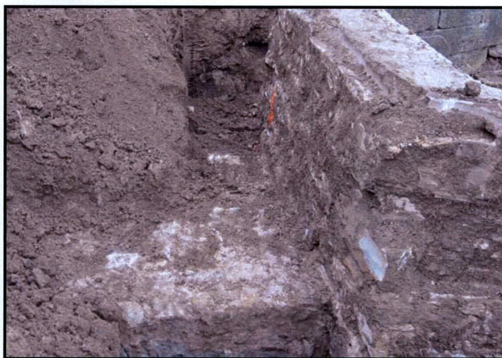
Figures 43 et 44 : Élévation et photographie de l'entrée de l'aqueduc n° 3 (localisée au sud du canal), mur arrière. Plan de Boudreau Fortier, architectes et photographies de Patrimoine Experts S.E.N.C., novembre 2008.
