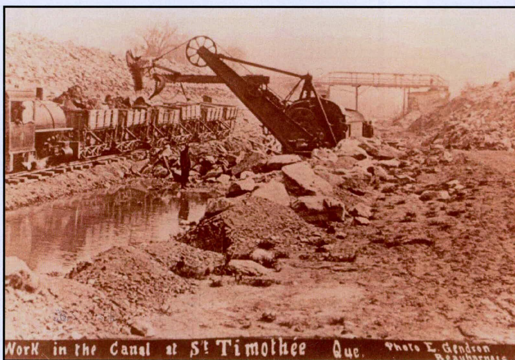
Figure 10 : Creusage du canal de Beauharnois à la hauteur de Saint-Timothée, vers 1906. Photographie de E. Gendron. Collection du Musée des Deux Rives, Salaberry-de-Valleyfield.
