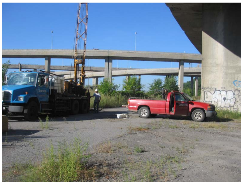
Photo n° 8. Foreuse à tarière évidée de type « CME-75 » montée sur un camion.
