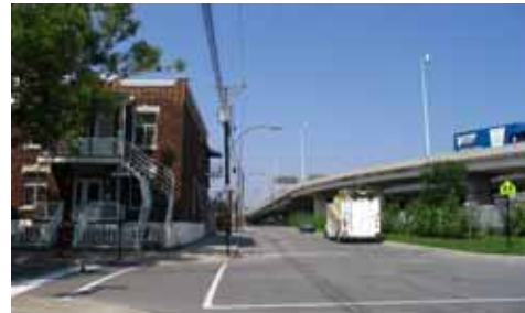
Les voies de l'A-15 dans le secteur Côte Saint-Paul (P4)
