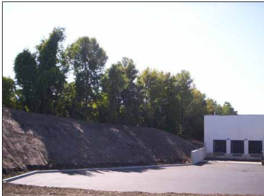
Boisé dans la zone industrielle au sud du canal de Lachine
