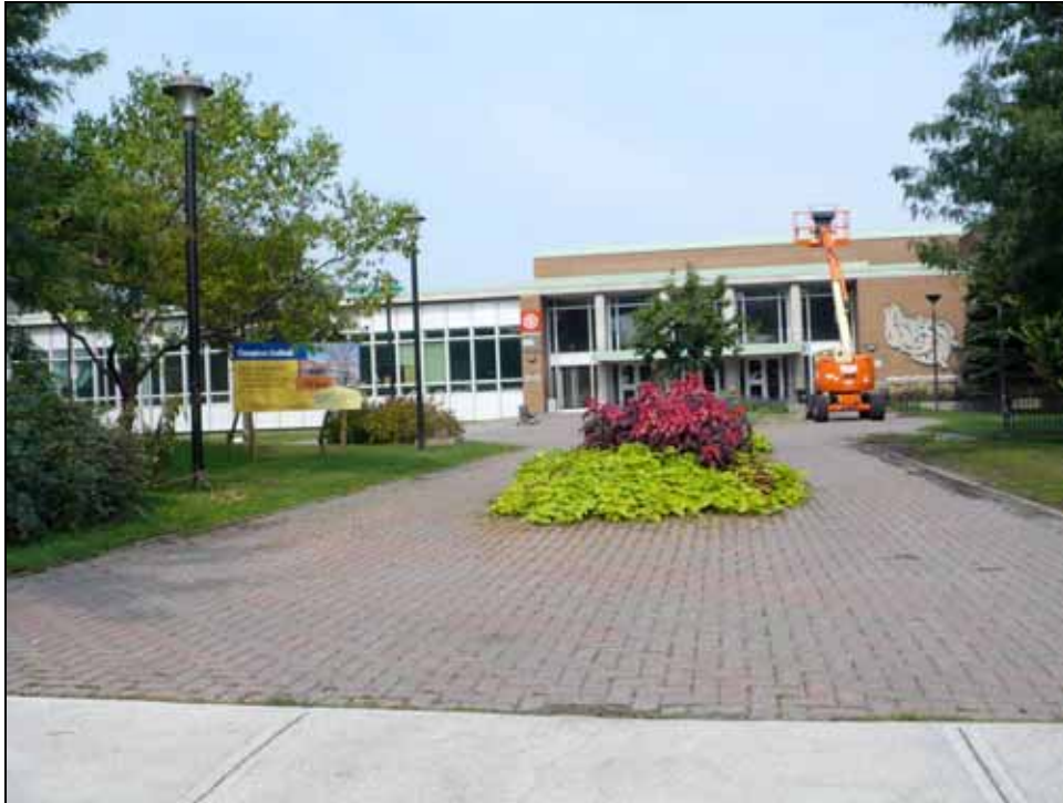
Centre récréatif Gadbois, situé au 5485, chemin de la Côte-Saint-Paul dans l'arrondissement du Sud-Ouest
