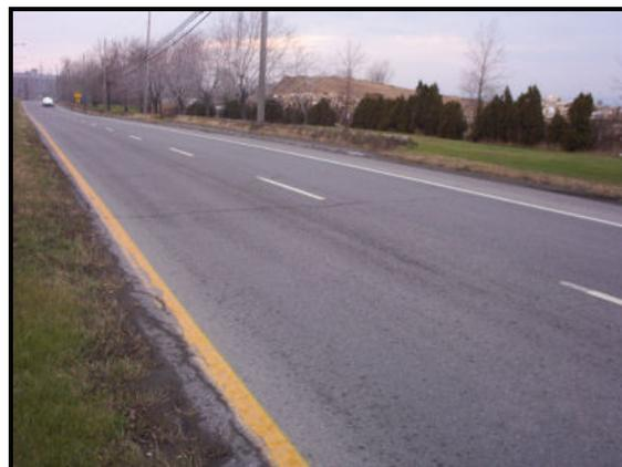
En conséquence, compte tenu de l'épaisseur totale insuffisante de la chaussée, il ressort qu'une reconstruction complète devrait être envisagée pour une mise à niveau de cette infrastructure. Cependant, en plus de l'option de la reconstruction de la chaussée, 2 autres options plus économiques sont également présentées dans ce rapport. Les 3 options analysées ne sont pas présentées par ordre d'importance. L'option à mettre en œuvre devra donc être choisie en fonction de différents facteurs.
