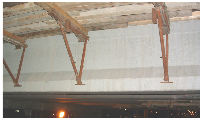
b) Abrasions multiples sur la semelle inférieure
