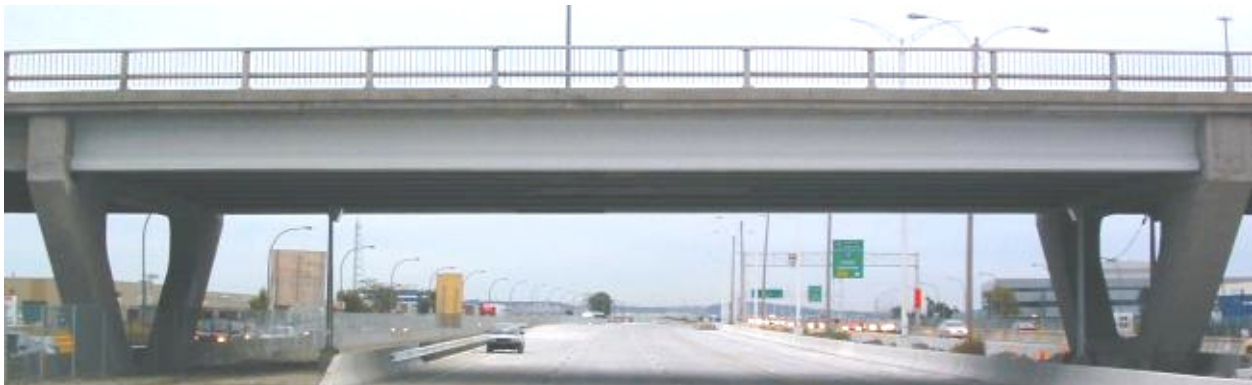
Figure 1 : Poutre ouest du pont d'étagement de la rue Halpern chemisée de PRFV (2004-09-17)
