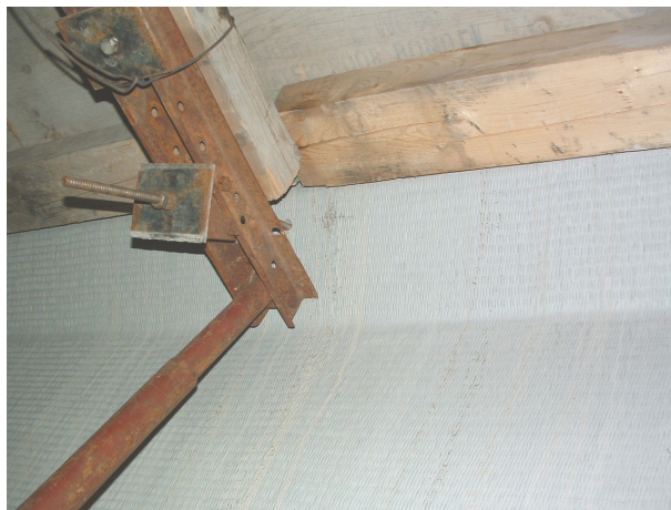
a) Perforation du PRFV pour ancrage
