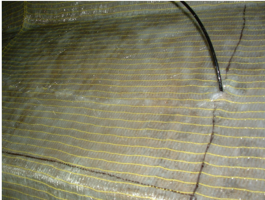
Figure 19 : Fibres de verre coupées pour les fils des électrodes de références dans la bande OC6 au pont de l'autoroute Chomedey (A-13) (2006-06-16)
