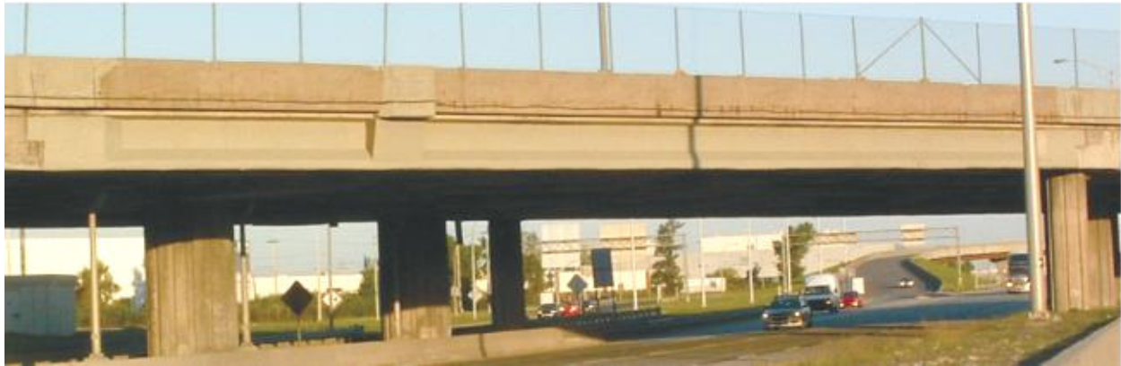
Figure 2 : Poutre est du pont d'étagement de l'autoroute Chomedey (A-13) chemisée de PRFV (2009-06-24)
