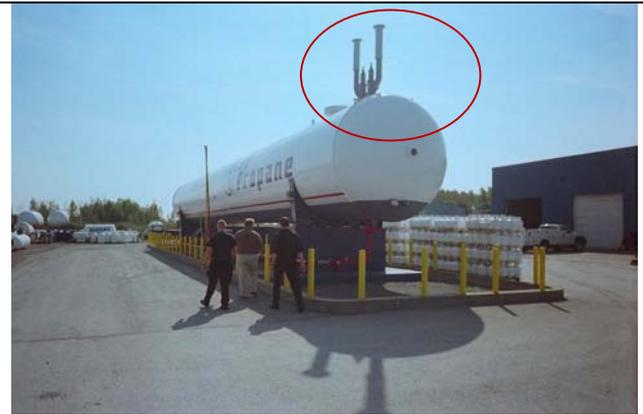
**Figure 3: Système de valve pour échappement de gaz propane due à une surpression**
