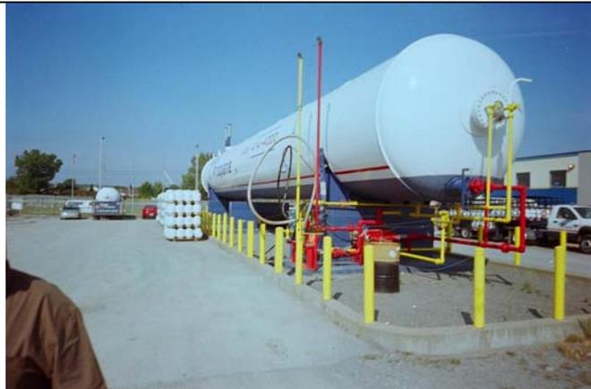
**Figure 2: Système de protection contre les collisions camions vs réservoir selon les normes.**
