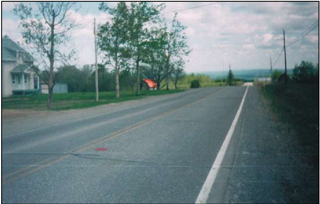
Photo 6 : Profil actuel de la route et perte de visibilité dans le secteur du cd. 4+200 .Photo en direction nord-est.
