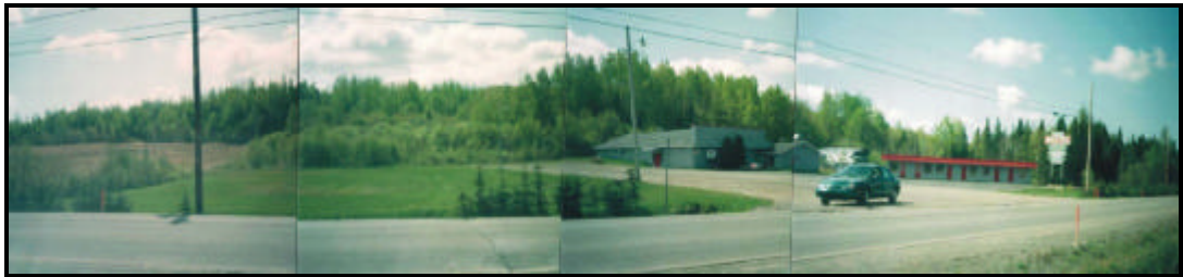
Photo 1 : A partir de l'entrée du lot 21, au chaînage 4+630d, vue d'ensemble des bâtiments du motel Chevalier et l'entrée à ce commerce, entre les ch 4+640 et 4+660g. Photo en direction sud.
