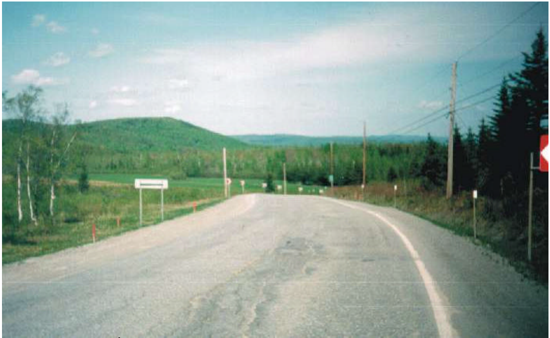
Photo 8 : À partir du centre de la chaussée au ch. 3+040, aperçu de la deuxième courbe signalée par des chevrons. Perte de visibilité et profil accidenté. Vue vers le nord-est.
