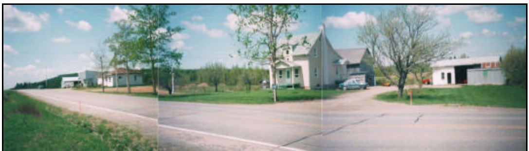
Photo 3 : A partir du ch 4+240g, prise de vue en direction ouest vers la résidence n° 225. À remarquer aussi la perte de visibilité en direction sud ouest.
