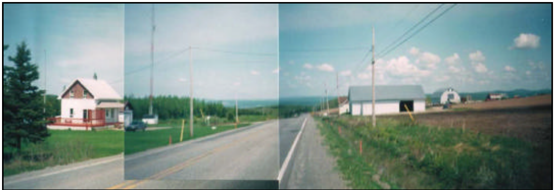
Photo 11 : Au ch. 3+700, vue en direction nord-Est. À gauche, au ch. 3+650d, résidence no. civique 130. Le hangar blanc situé au ch. 3+600g, se retrouvera dans l'emprise.
