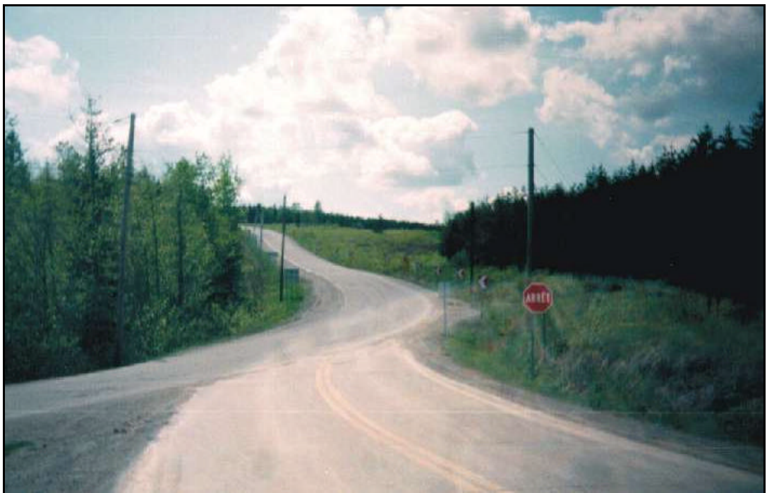
Photo 9 : À partir de l'intersection actuelle des trois routes, vue vers Cabano (vers l'ouest) des courbes prononcées à corriger.
