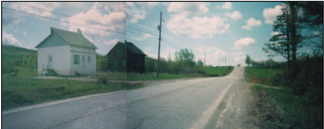
Photo 10 : Du ch. 4+000, vue en direction sud-ouest, nouvelle résidence no. civique 180 (au ch. 4+030g) construite à proximité d'une maison abandonnée.
