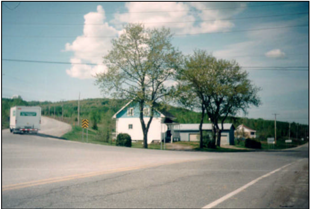
Photo 13 : Résidence n°. civique 1 route 232 coincée à l'intersection des routes. Vue en direction nord.
