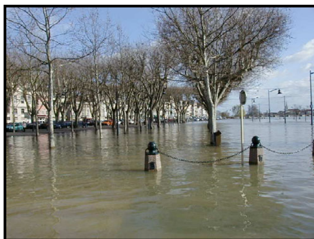
Photo 6 : Éclairage public sur l'esplanade Lamartine
