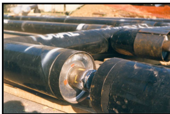
Photo 13 : Double enveloppe de la technique Tugal (source Compagnie Générale des Eaux)
