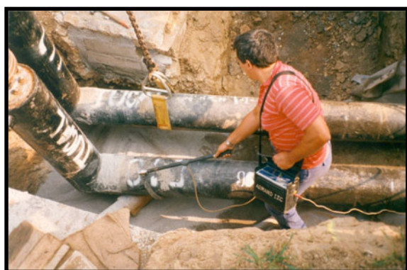
Photo 12 : Mise en œuvre de la technique Tugal (source Compagnie Générale des Eaux)
