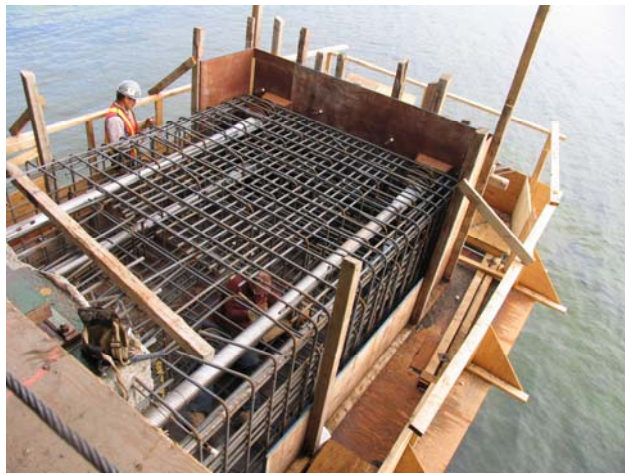
Photo 9 : Aciers d'armature et de précontrainte aux extrémités des nouveaux chevêtres
