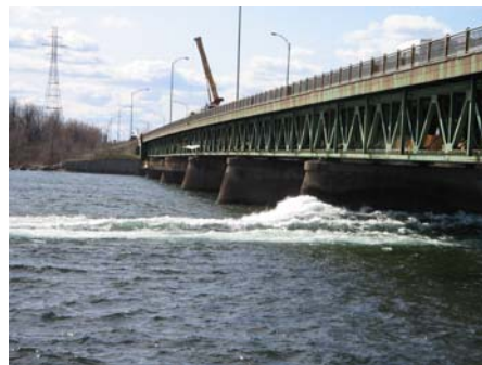
Photo 1 : Vue amont du Pont Monseigneur-Langlois n°1 avant les travaux
