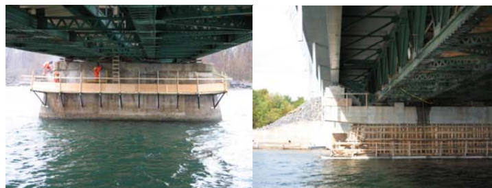
Avant Après Photo 8 : Fûts et nouveaux chevêtres des piles
