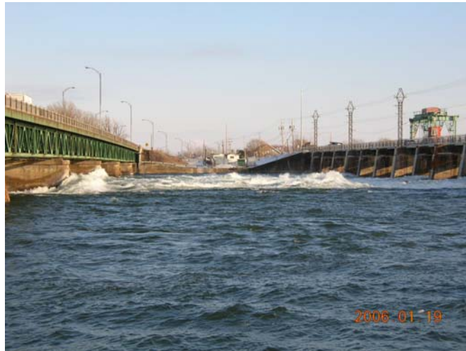
Photo 5 : Impact de l'ouvrage de régulation sur l'écoulement des eaux aux piles du pont
