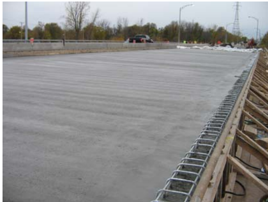
Photo 16 : Dalle et chasse-roue de la dernière phase des travaux
