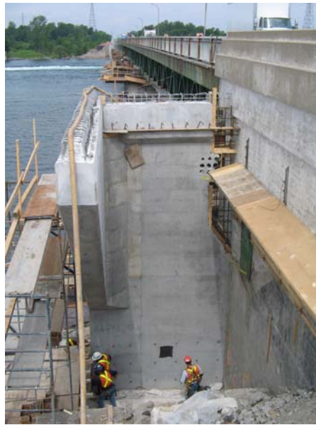
Photo 7 : Travaux d'élargissement d'une culée, hauteur totale de plus de 10 m
