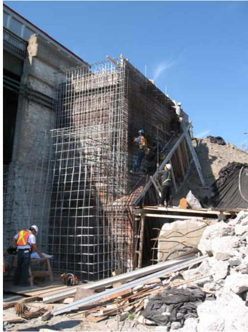
Photo 19 : Acier d'armature de l'élargissement de culée
