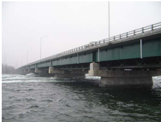
Photo 3 : Vue amont du pont Monseigneur-Langlois après les travaux
