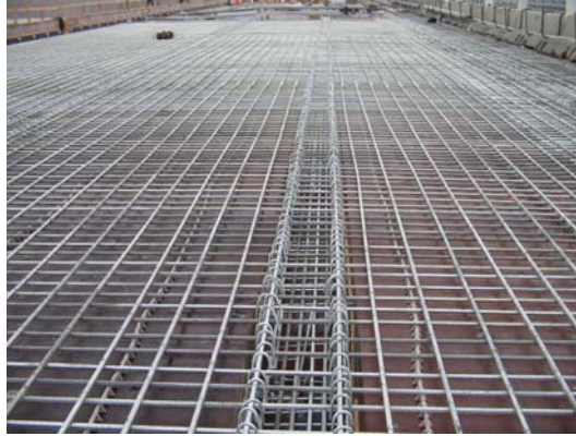
Photo 15 : Acier d'armature de la dalle et des poutrelles
