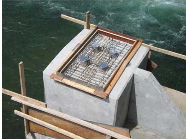
Photo 11 : Socle d'appui des nouvelles poutres
