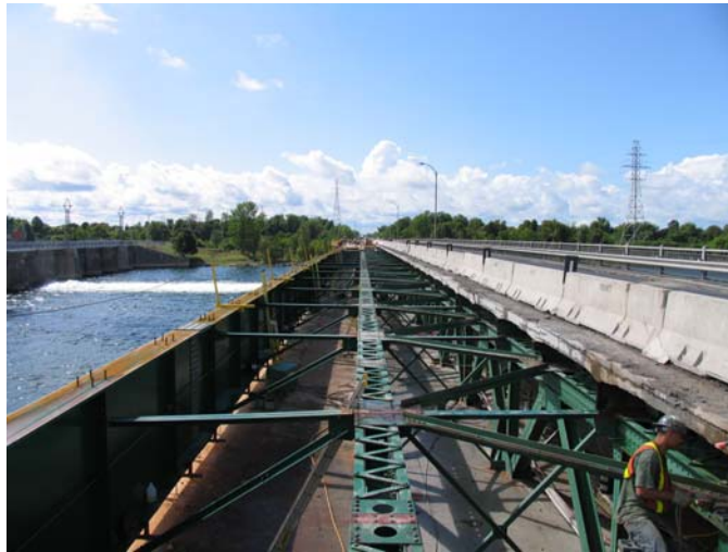
Photo 13 : Première phase des travaux de remplacement de dalle
