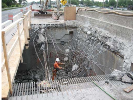
Photo 17 : Modification des culées creuses
