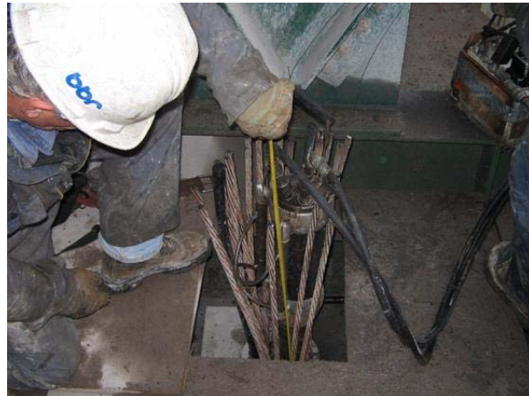
Photo 10 : Armature de précontrainte des ancrages au roc
