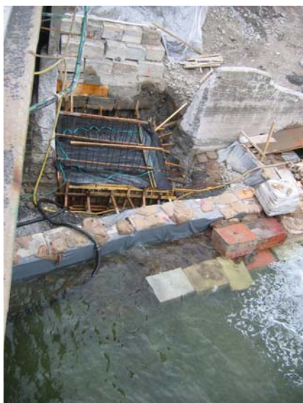
Photo 4 : Batardeau pour l'élargissement d'une culée
