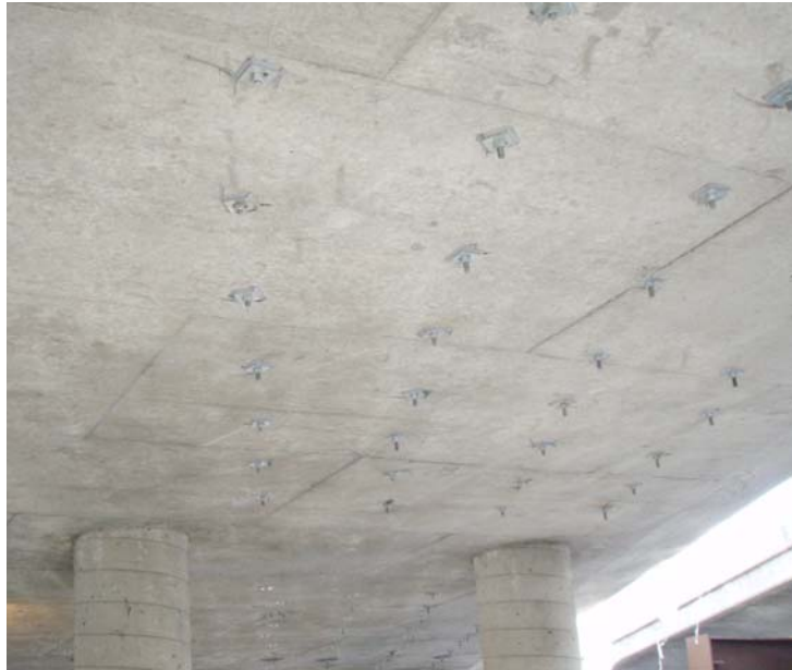
Figure 3 – Ancrages en place au-dessous de la dalle
