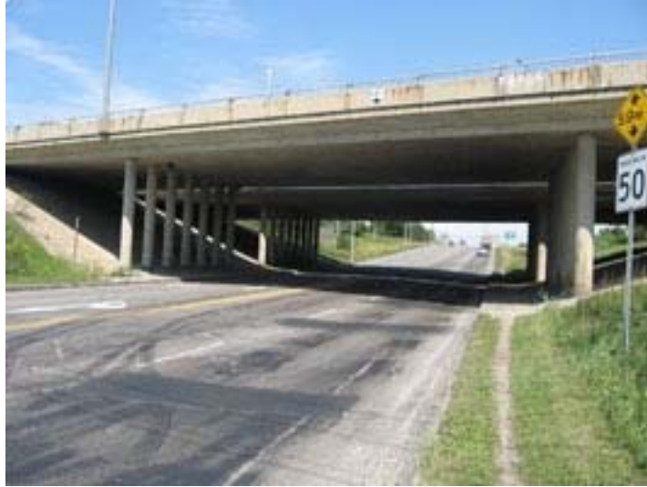
Figure 1 – Vue générale des structures
