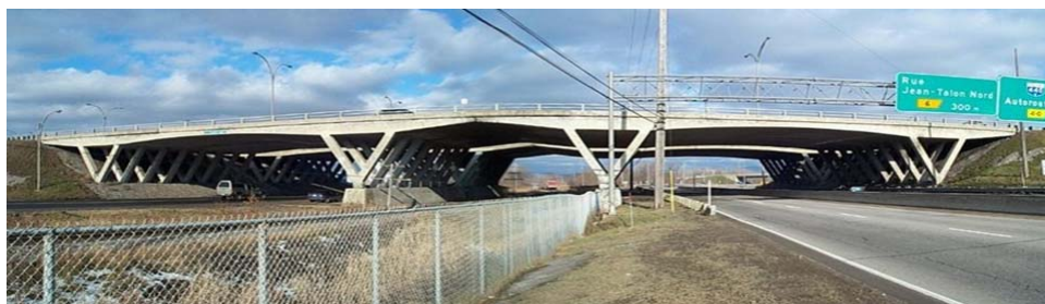
Figure 4 – Vue générale des structures
