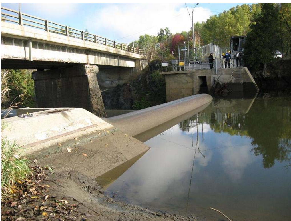
Fig. 1: Photographie du barrage Eustis
