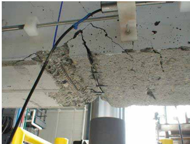
Figure 8 – Mode de rupture pour L2
