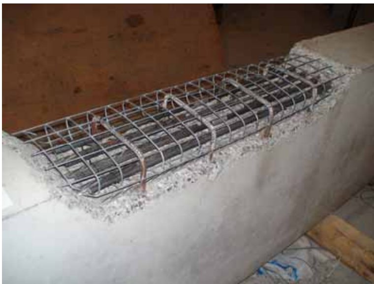
Figure 4 - Renforcement de la zone réparée pour la poutre L2
