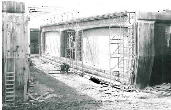
Figure 3 - Construction d'un des éléments du tunnel Louis-Hippolyte-La Fontaine 1
