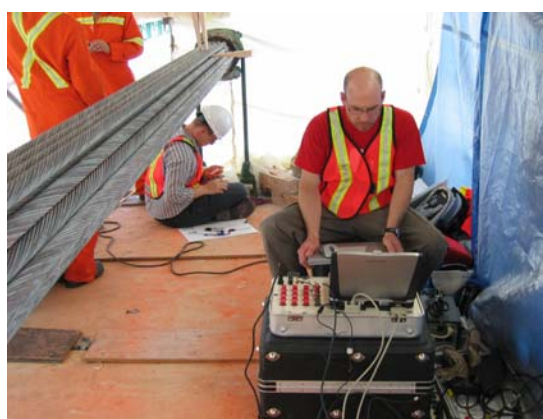
Figure 13 : Tests de vibromètre laser
