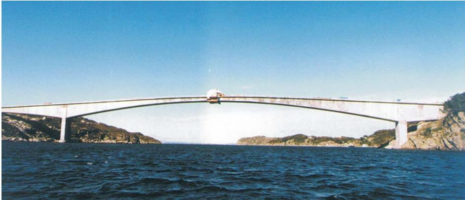
Figure 2 – Pont Stolma en Norvège utilisant un béton léger
