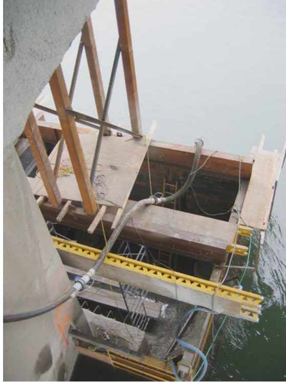
Figure 7 – Batardeau mis en place
