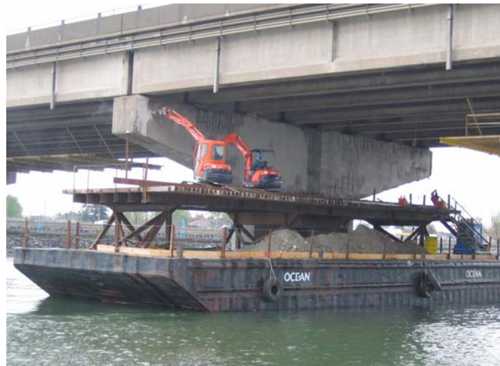
Figure 6 – Démolition en surface des chevêtres
