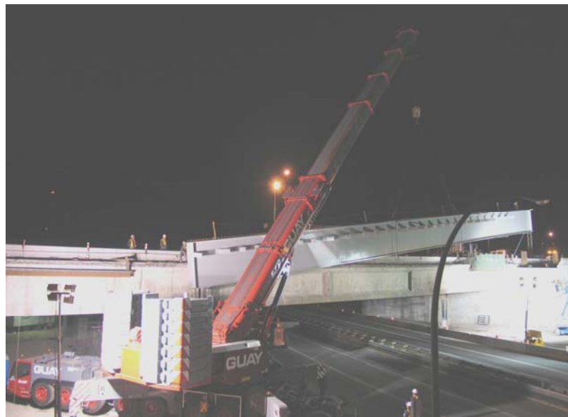
Figure 9 – Pose de la poutre au-dessus de la route 132
