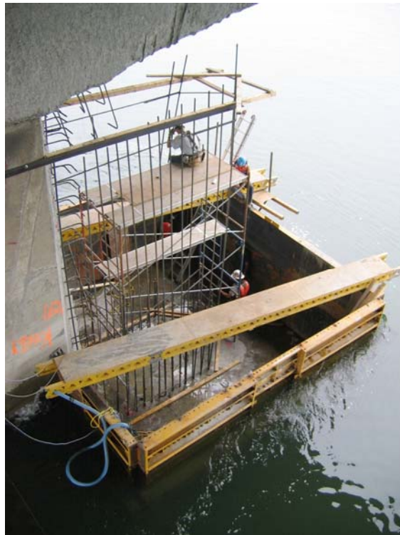
Figure 7 – Élargissement du fût des piles
