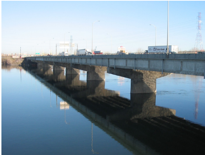
Figure 1 – Vue générale vers le nord
