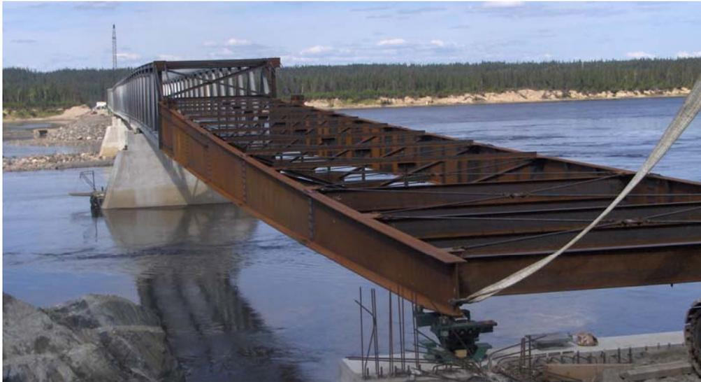
**PHOTO DU PONT AVEC BEC SUR RIVE OPPOSÉE**
