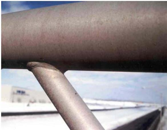
*Note : Mauvaise position d'un trou de ventilation requis lors du soudage; le percement sur le dessus de la membrure diagonale permet à l'eau d'entrer dans la membrure. En l'absence d'un point de drainage au bas de la membrure, l'eau s'accumule; le gel causera alors la rupture de la membrure.*
