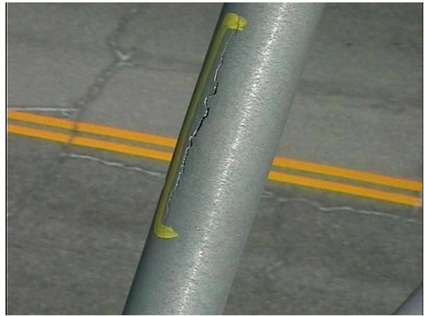
*Note : Fissure longitudinale dans une membrure diagonale; en gelant, la glace formée aura suffisamment d'expansion pour fendre la membrure.*
