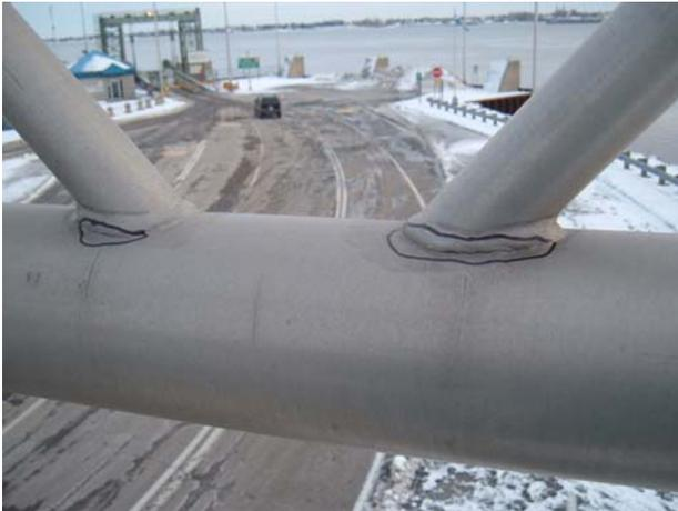
*Note : Assemblages excentriques. Les nouvelles poutres T1 à T4 ont des joints concentriques.*
