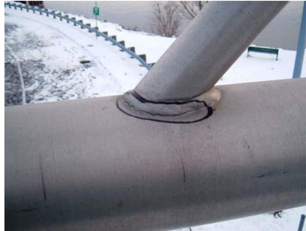
*Note : Fissure se propageant dans l'assemblage soudé.*
