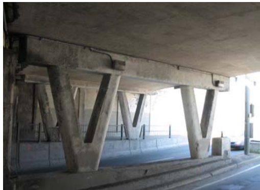
Figure 2 – Coupe transversale du tablier et vue des piles de la structure routière.
