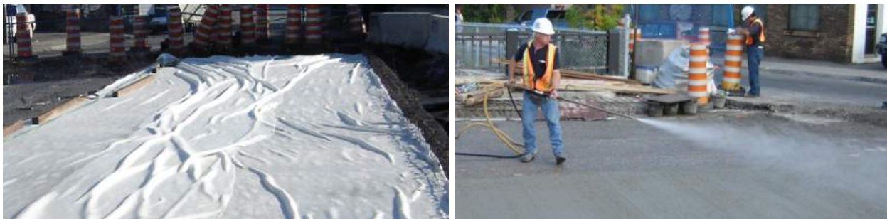
Figure 11 – Mûrissement des bétons de resurfaçage.
