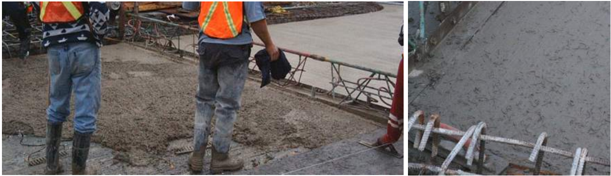
Figure 10 – Mise en place des bétons.
