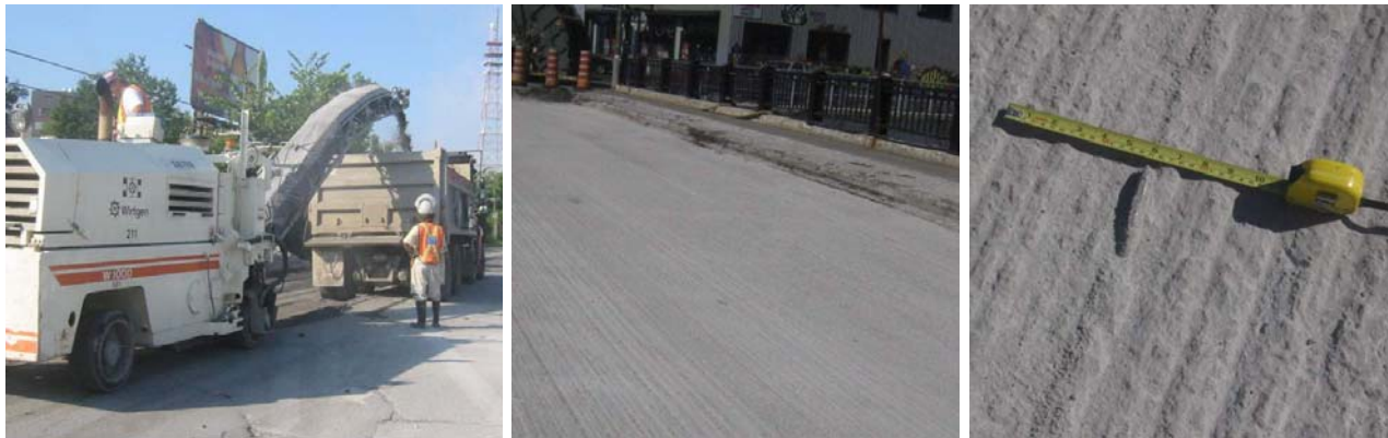
Figure 8 – Scarification de la surface du tablier.
