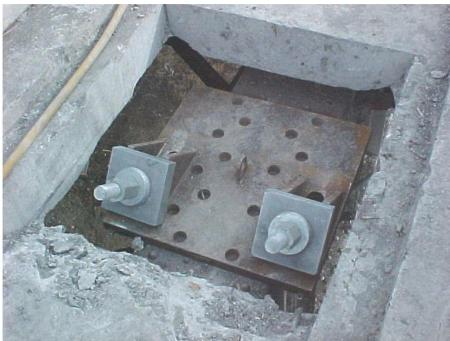
Figure 6 – Pose des renforcements en chantier
