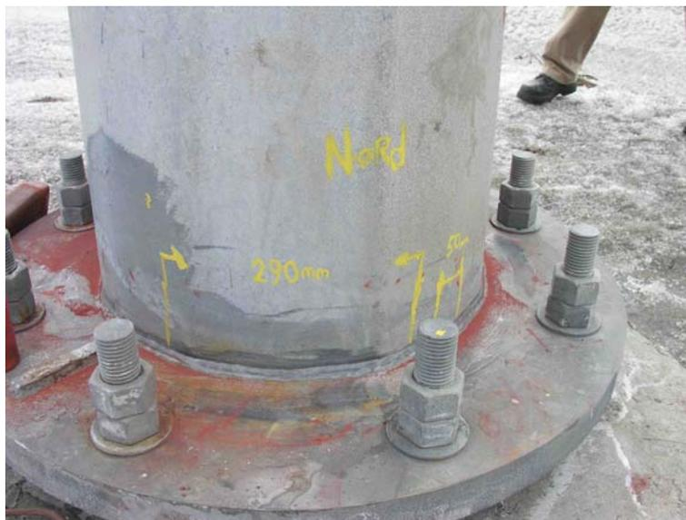
Figure 4 : Fissuration du fût d'une tour en service
