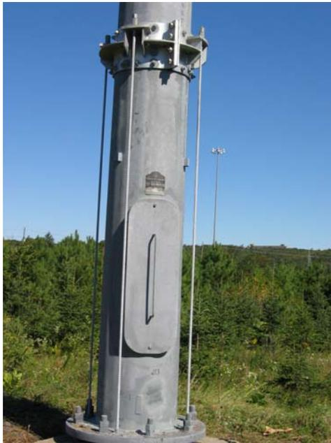
Figure 7 : Système de renforcement d'une tour d'éclairage
