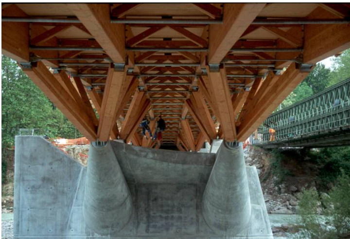
Pont de Crest - Stabilisation transversale de la structure en sous-face
