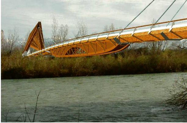
Passerelle sur le Drac - Le tablier soutenu par haubanage pour une portée libre de 110 m
