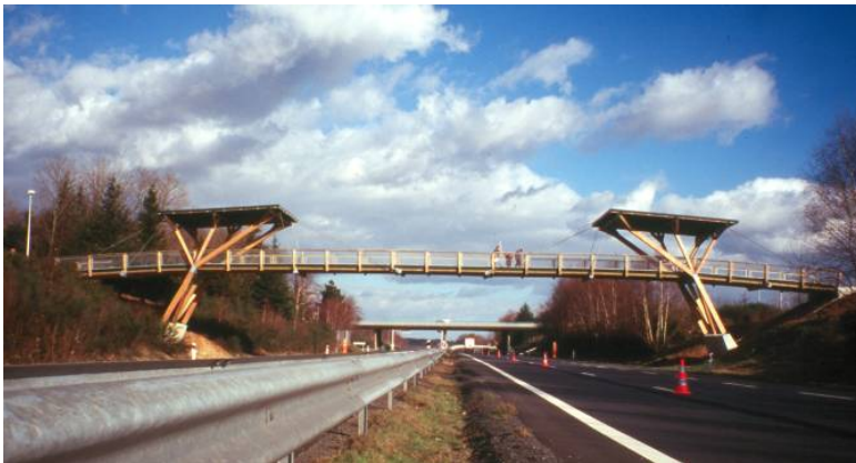
Franchissement d'une autoroute par une passerelle de 57 m
