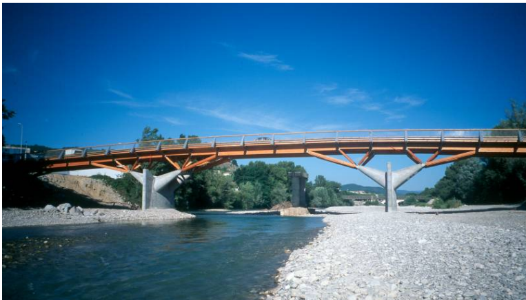
Pont de Crest - Pont routier franchissant la Drome sur 94 m
