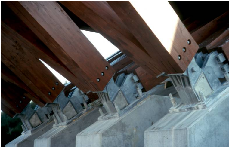
Des assemblages de taille et de poids pour distribuer des efforts de 500 tonnes
