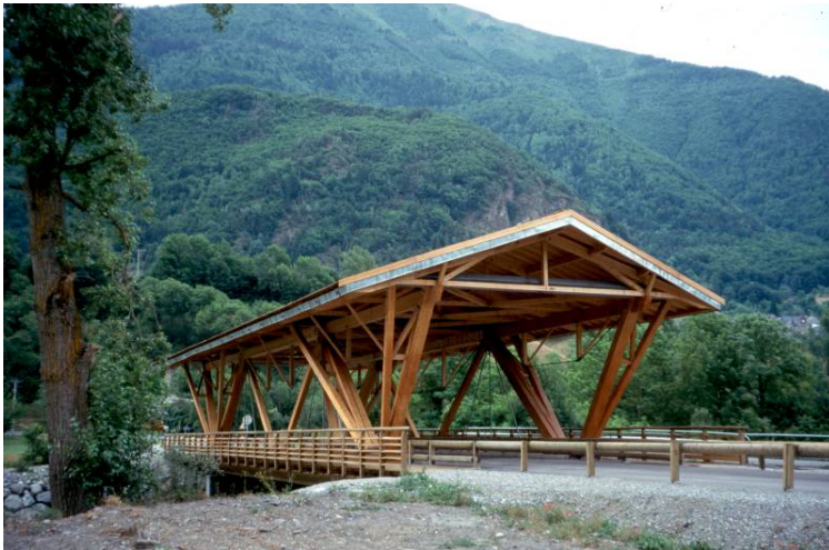
Pont des Fayettees - ouvrage tri-composite de dernière technologie
