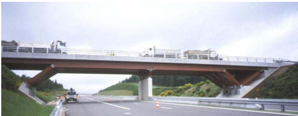
Le pont routier qui franchit l'autoroute A89 sur 56 m
