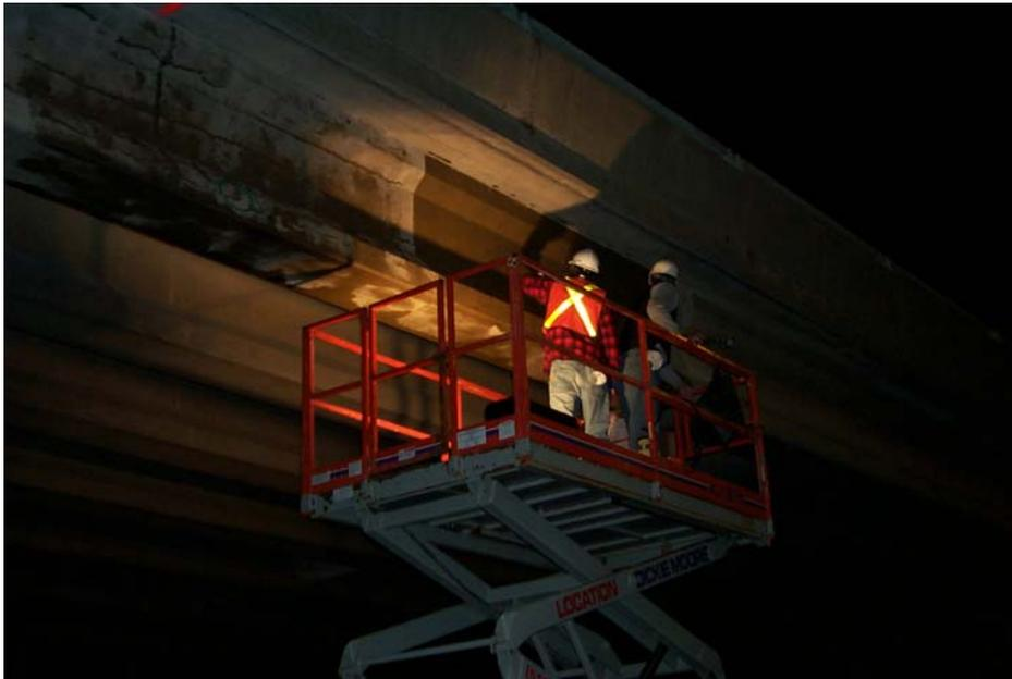
Photo n° 2 : Application d'enduit sur la poutre de rive sud
