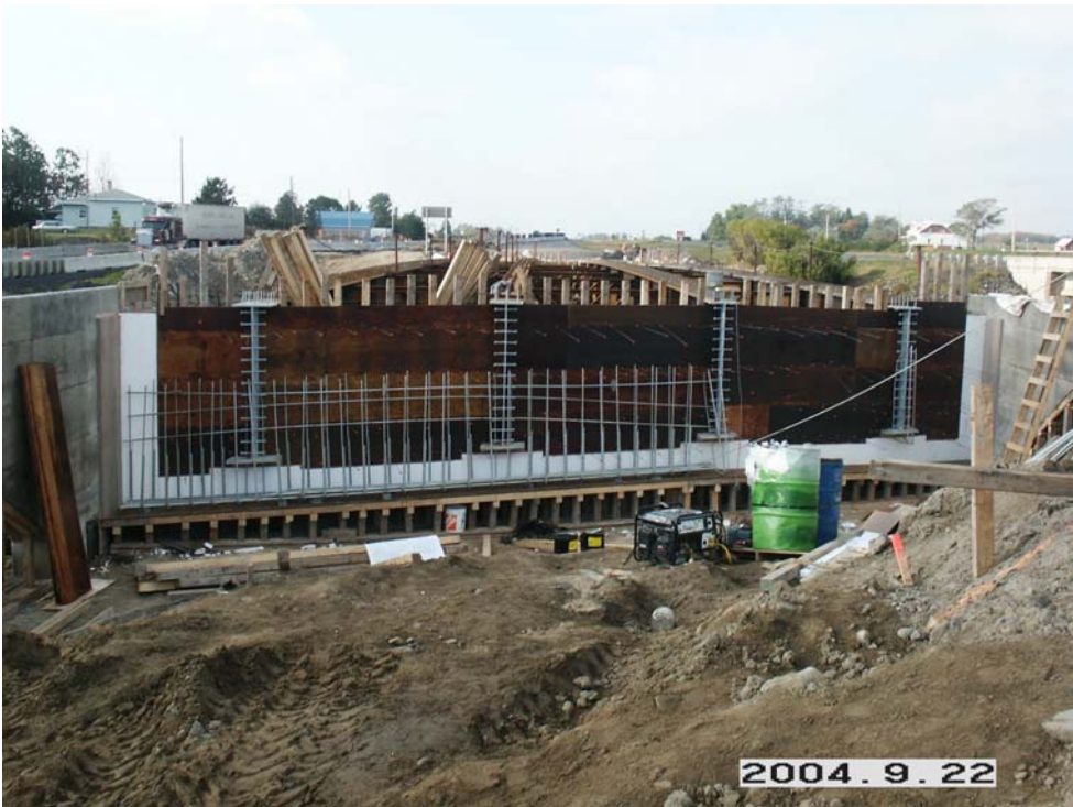
Construction d'un diaphragme d'extrémité Pont de Val-Alain
