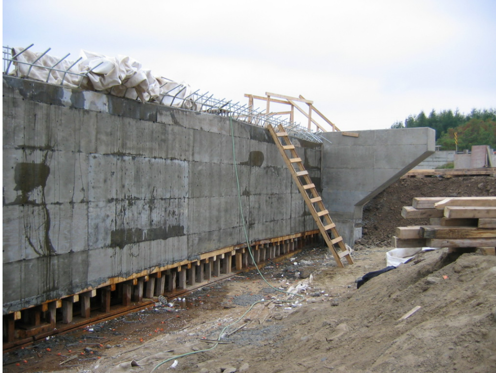
Construction d'un diaphragme d'extrémité Pont de Val-Alain
