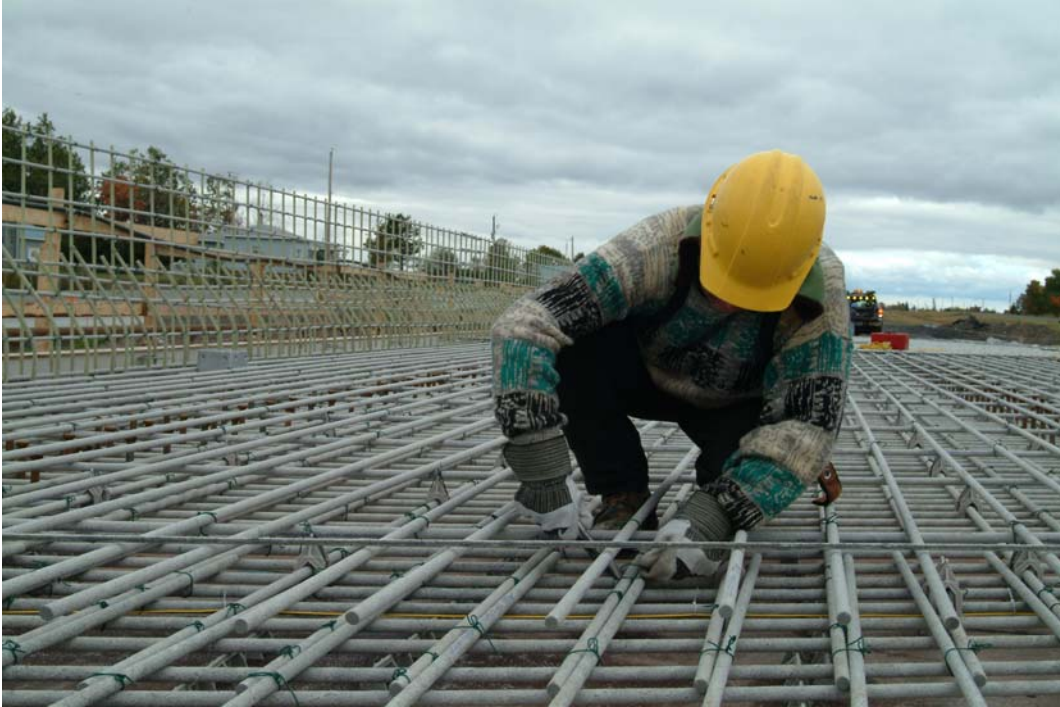
Installation d'armatures en matériaux composites Pont de Val-Alain
