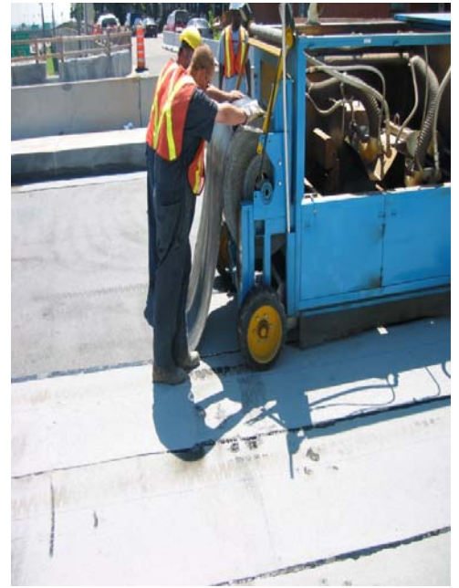
15- Pose de la membrane
