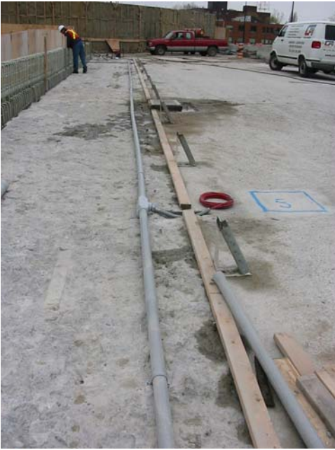
1- Pose conduit principal des câbles du système
