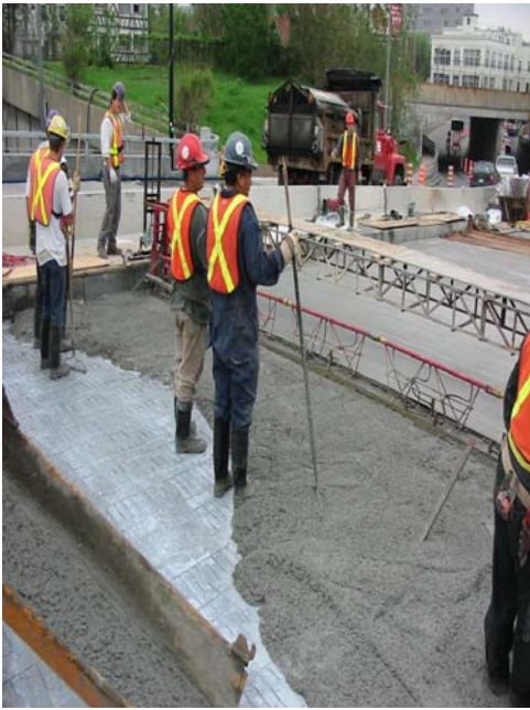
13- Pose de la chape de béton
