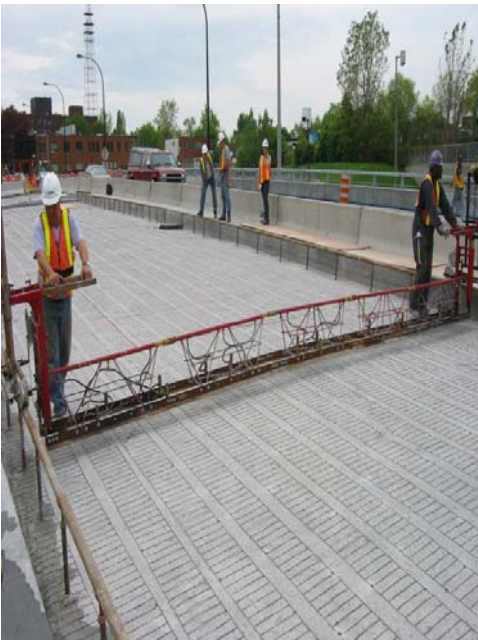
10- Préparatifs avant la pose de la chape de béton
