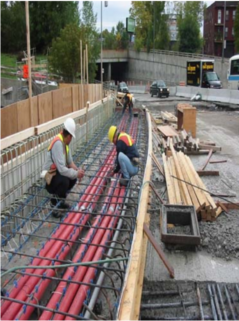
7- Pose anode trottoir
