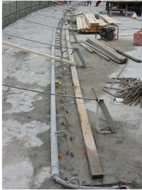
2- Pose conduit principal des câbles du système
