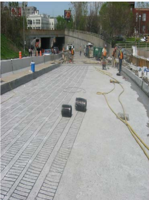
4- Pose anode sur la dalle
