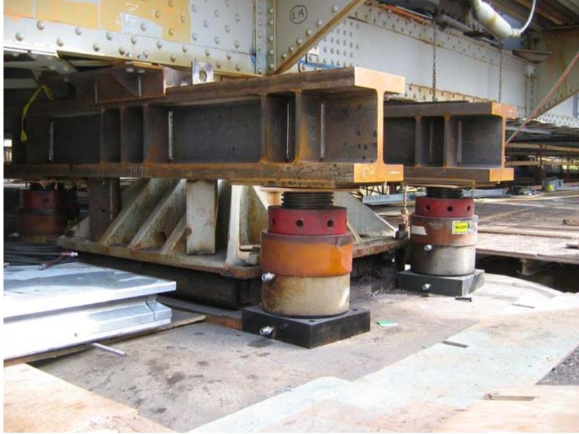
**Figure 8 : Travaux de remplacement d'appareils d'appui**
