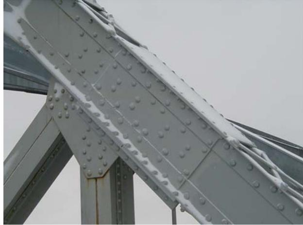
**Figure 7 : Remplacement de diagonales d'extrémité**
