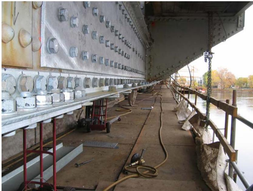
**Figure 6 : Membrures inférieures réparées**
