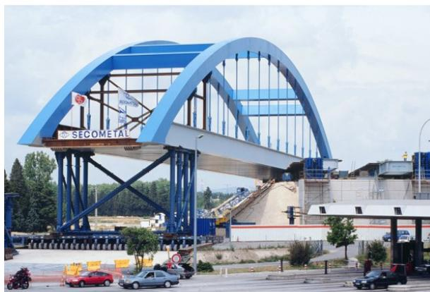
Figure 7 – Lançage sur pneus du pont à arc de Bonpas, France
