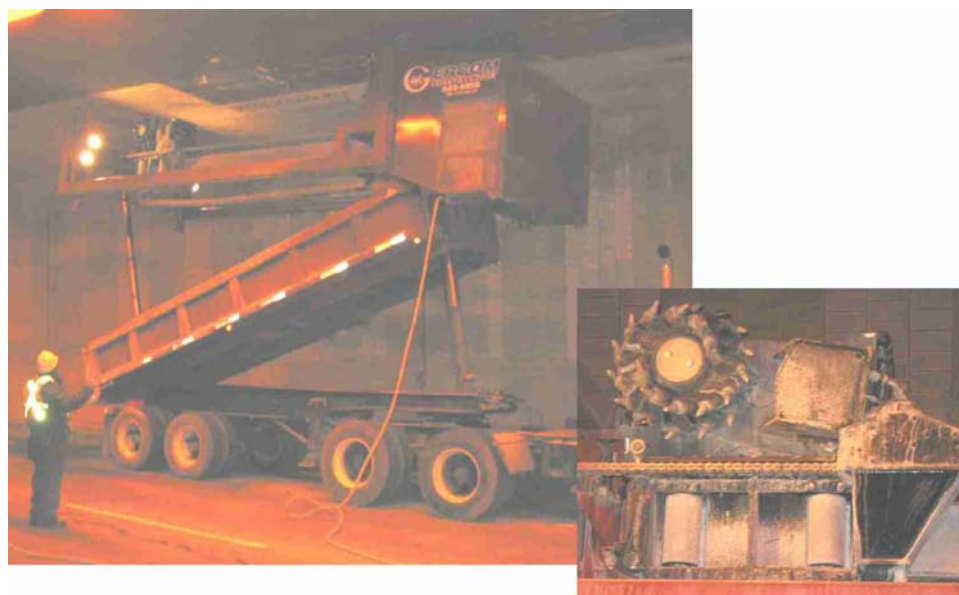
Figure 4 – Fraiseuse à béton sur la voûte et détail de la tête
