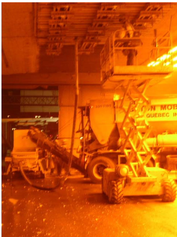
Figure 6 – Bétonnage typique et appareillage utilisé
