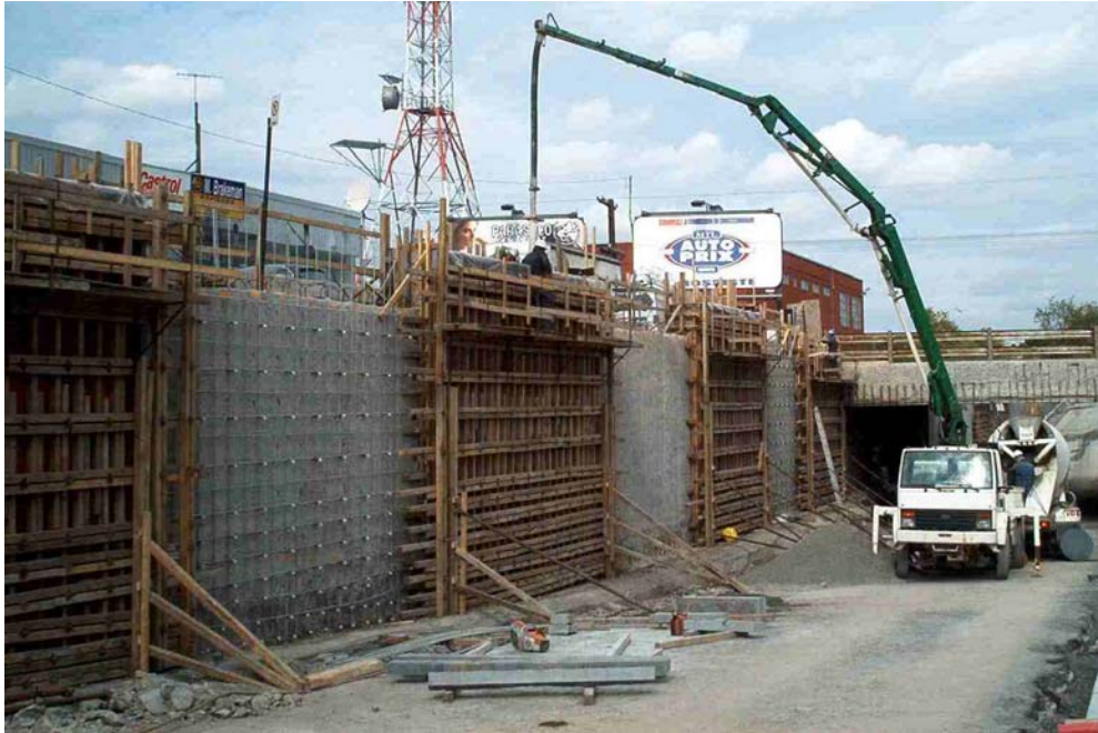
Figure 3 : Mise en place du béton autoplaçant
