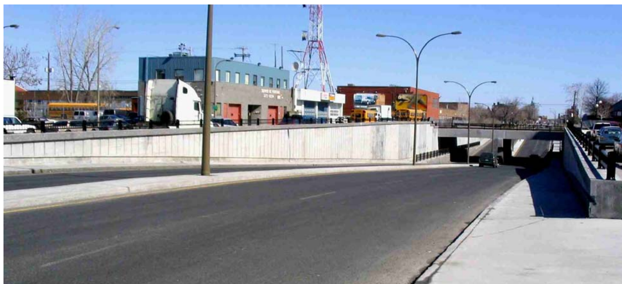
Figure 5 : Passage inférieur Jarry/Querbes tel que construit
