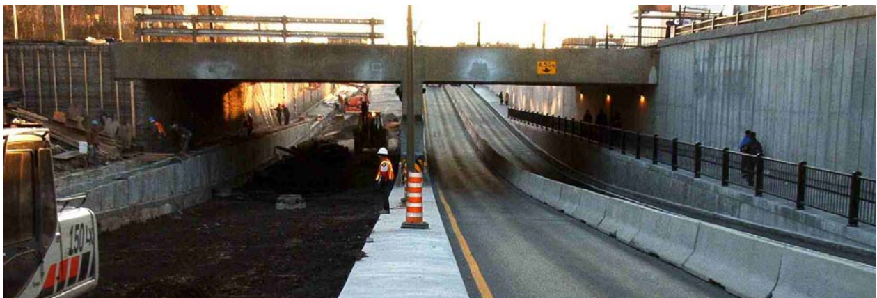
Figure 4 : Construction par phase
