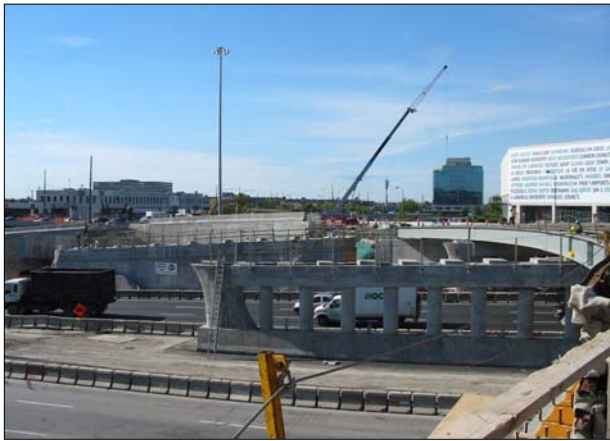
Figure 10 : Culée et pile centrale lors de l'érection de la charpente
