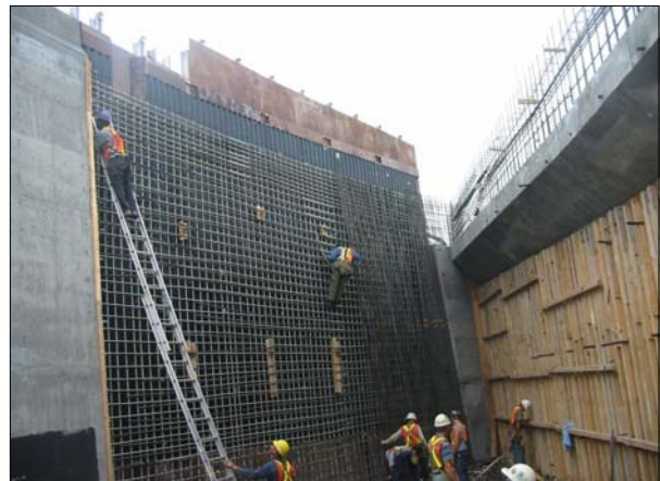
Figure 8 : Pose de l'armature d'une culée
