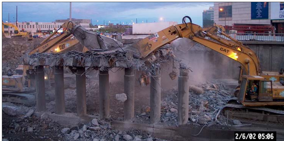
Figure 9 : Démolition du pont Est
