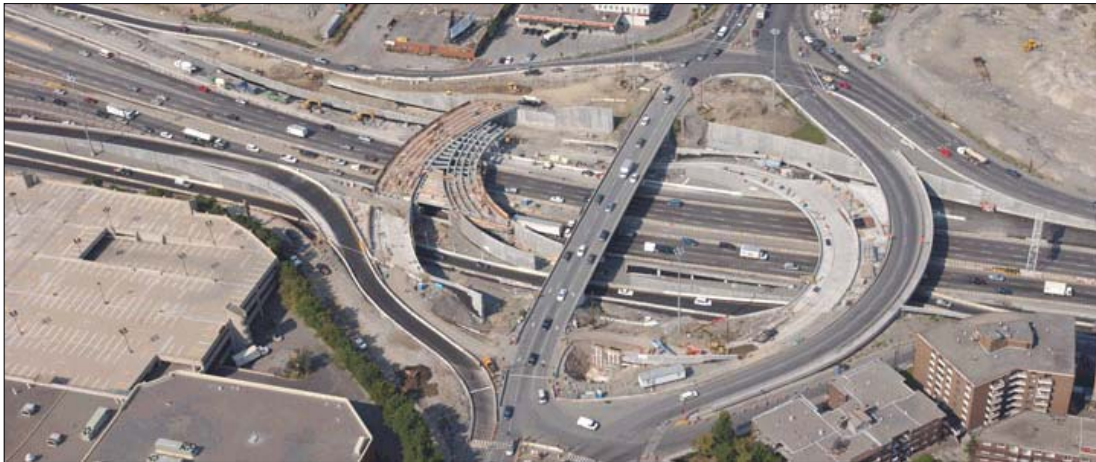
Figure 12 : Vue aérienne du chantier au 10 septembre 2003
