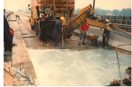
Un matériau anodique en forme de treillis de type MMO a été posé sur le béton de la dalle de sorte à couvrir une surface s'étalant entre deux joints de dilatation, tel que le montre la photo 6.
