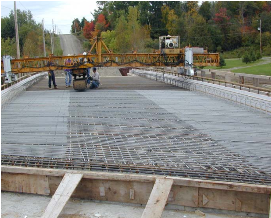
Fig. 2 Armature du pont Wotton
