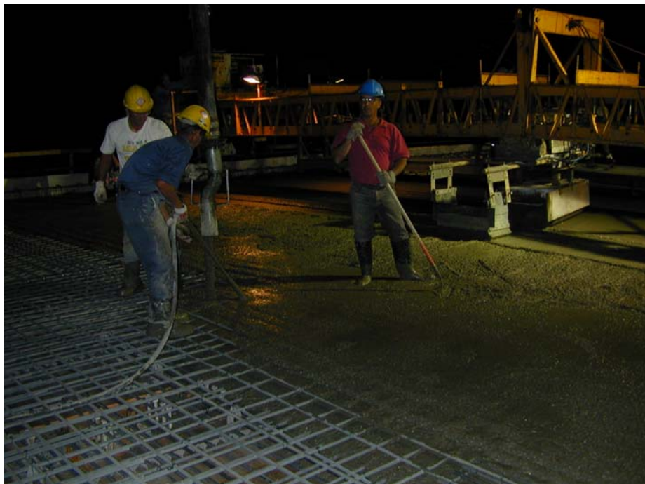
Fig. 4 Bétonnage de la dalle du pont Magog
