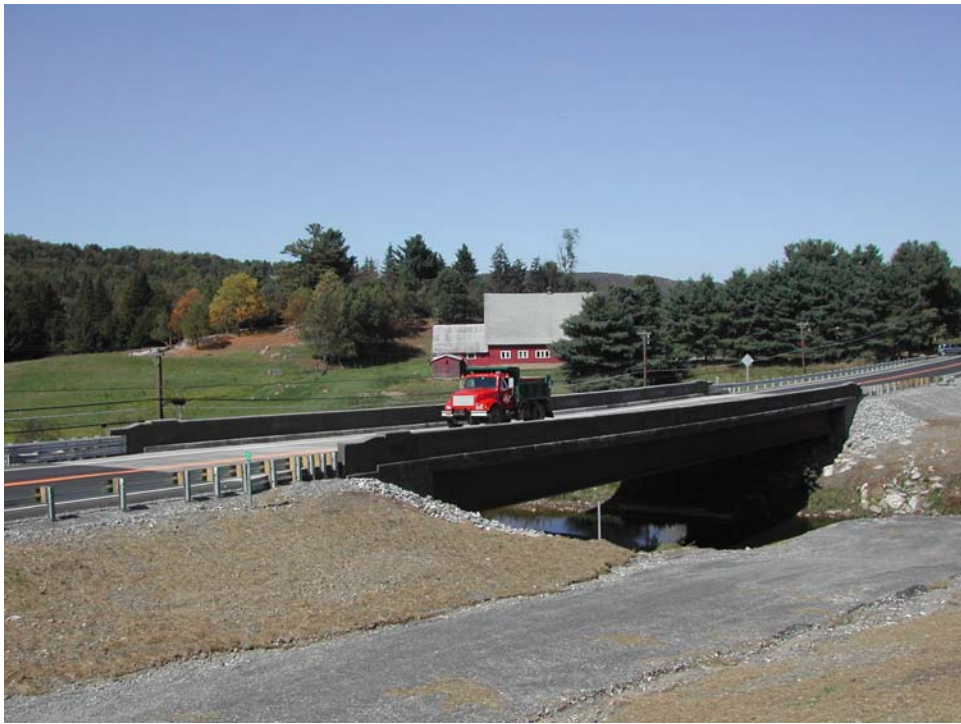
Fig. 6 Vue du pont Morristown
