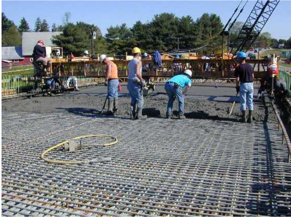
Fig. 5 Bétonnage de la dalle du pont Morristown
