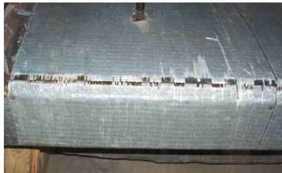
Figure 6 : Rupture du chemisage sur l'arête de la plaque d'acier
