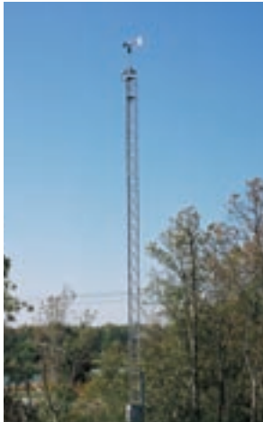
Le Système avancé d'information sur les conditions routières et météorologiques (SAICRM) surveille les conditions météorologiques et routières.
