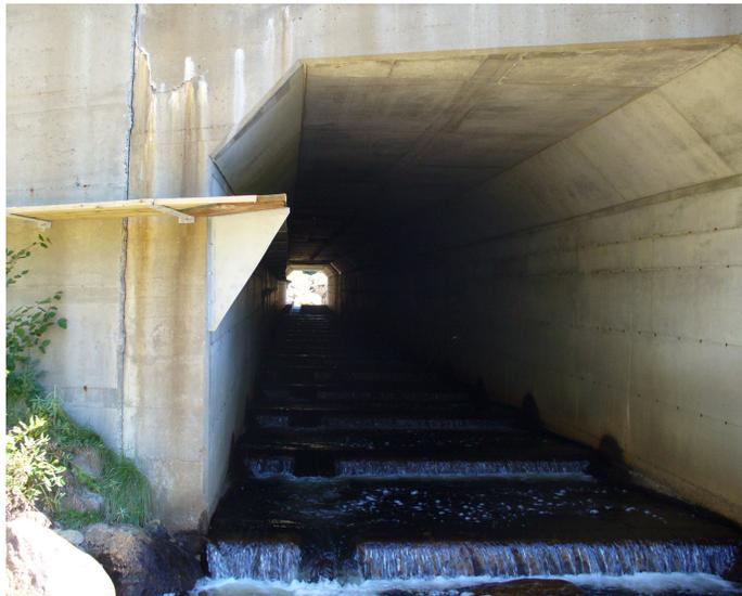
Figure 5.13 Photo d'un ponceau sous la route 175 comportant une tablette pour la petite faune et des déversoirs pour la faune aquatique. Photo : Mélanie Bouffard
