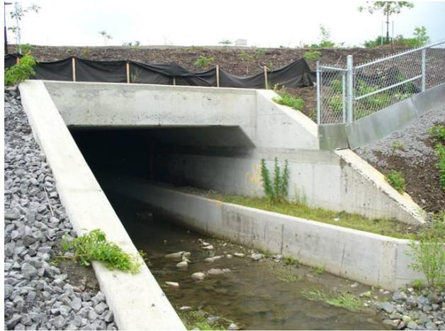
Figure 5.9 Ponceau comportant un pied sec construit et jumelé à une clôture à petite faune doublée de tôle enfouie. Photo : Mélanie Bouffard
