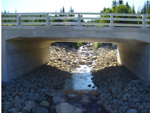
Figure 3.11 Photo du lit majeur en construction du ruisseau Bureau dans la RFL. Photo : Mélanie Bouffard
