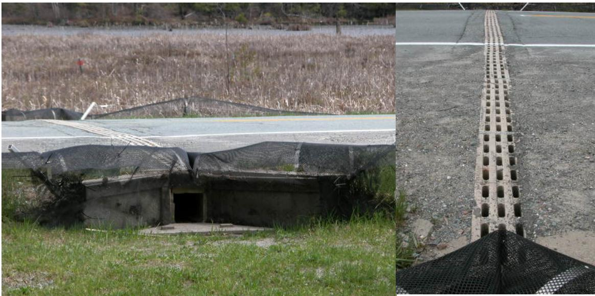
Figure 5.4 Un des trois passages à amphibiens du lac Brompton et ses ailes de béton jumelées au grillage collecteur. Photos : Timothée Ostiguy
