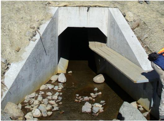
Figure 5.14 Photo d'un passage de type tablette en porte-à-faux dans la RFL. Photo : Mélanie Bouffard
