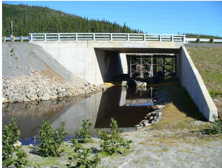
Figure 5.15 Passage aménagé sur une berge de la décharge du lac Horatio-Walker dans la RFL sous la route 175 (en construction). Photo : Mélanie Bouffard
