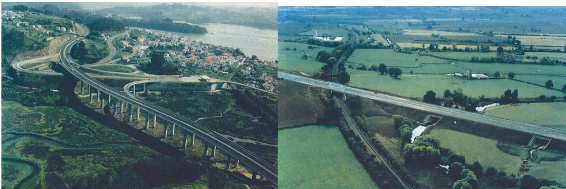
Figure 3.2 Photos comparant une structure (Espagne) et un remblai (Royaume-Uni) pour traverser le fond d'une vallée. Tiré de Iuell *et al.* (2007, p.61)
