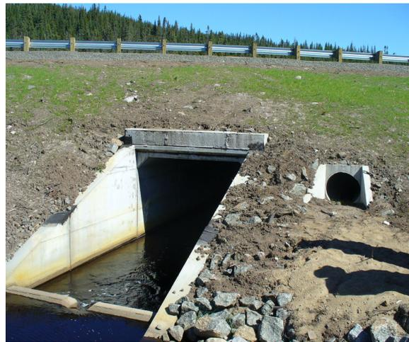
Figure 3.9 Tuyau sec de 60 cm à proximité du ponceau du ruisseau des Brûlés sous la route 175.
