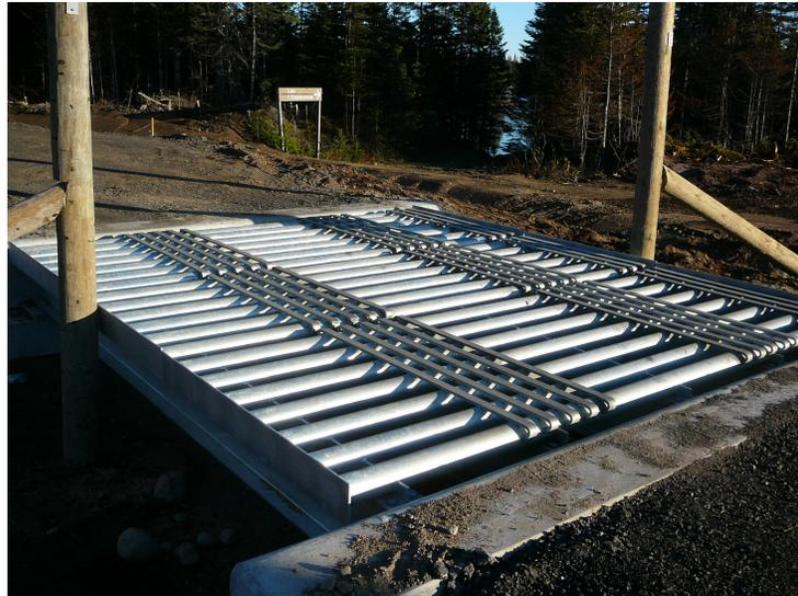
Figure 3.14 Passage anti-cervidé jumelé à la clôture à grande faune (en construction) dans la RFL. Photo : Yves Leblanc
