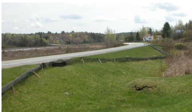
Figure 5.2 Vue d'ensemble de la clôture qui dirige les amphibiens vers les passages au lac Brompton. Photo :
