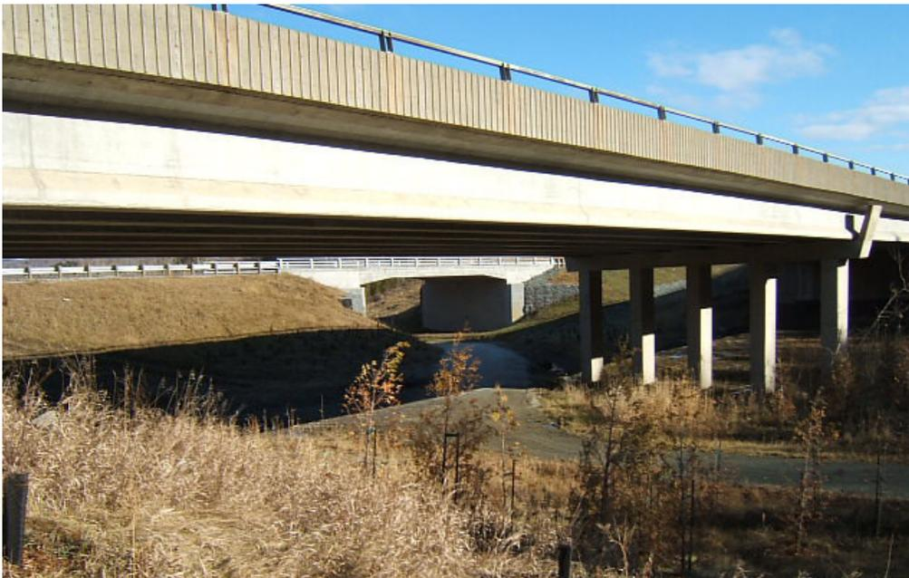
Figure 5.5 Passage mixte (vélo et faune) sous l'autoroute 55. L'ancienne construction est en premier plan et la nouvelle en arrière plan. Tiré de Gagné (2005).
