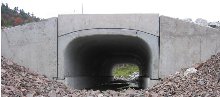
Figure 5.8 Passage de type « Conspan » pour le cerf de Virginie sous le prolongement de l'autoroute 50 dans les Laurentides (en construction). Photo : Jean Boulé.
