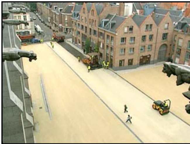
Figure 9: Béton bitumineux de couleur pâle pouvant être utilisé pour les surfaces réfléchissantes (Mexasphalt, Shell)
