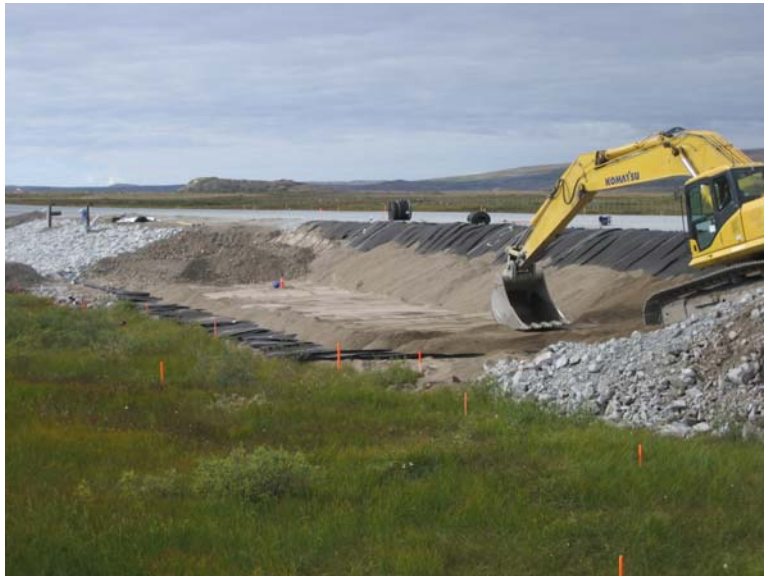
Figure 10 : Installation de la section expérimentale de drain thermique à côté de la section de remblai à convection (à gauche sur la photo) sur la piste d'atterrissage de Tasiujaq à l'été 2007.
