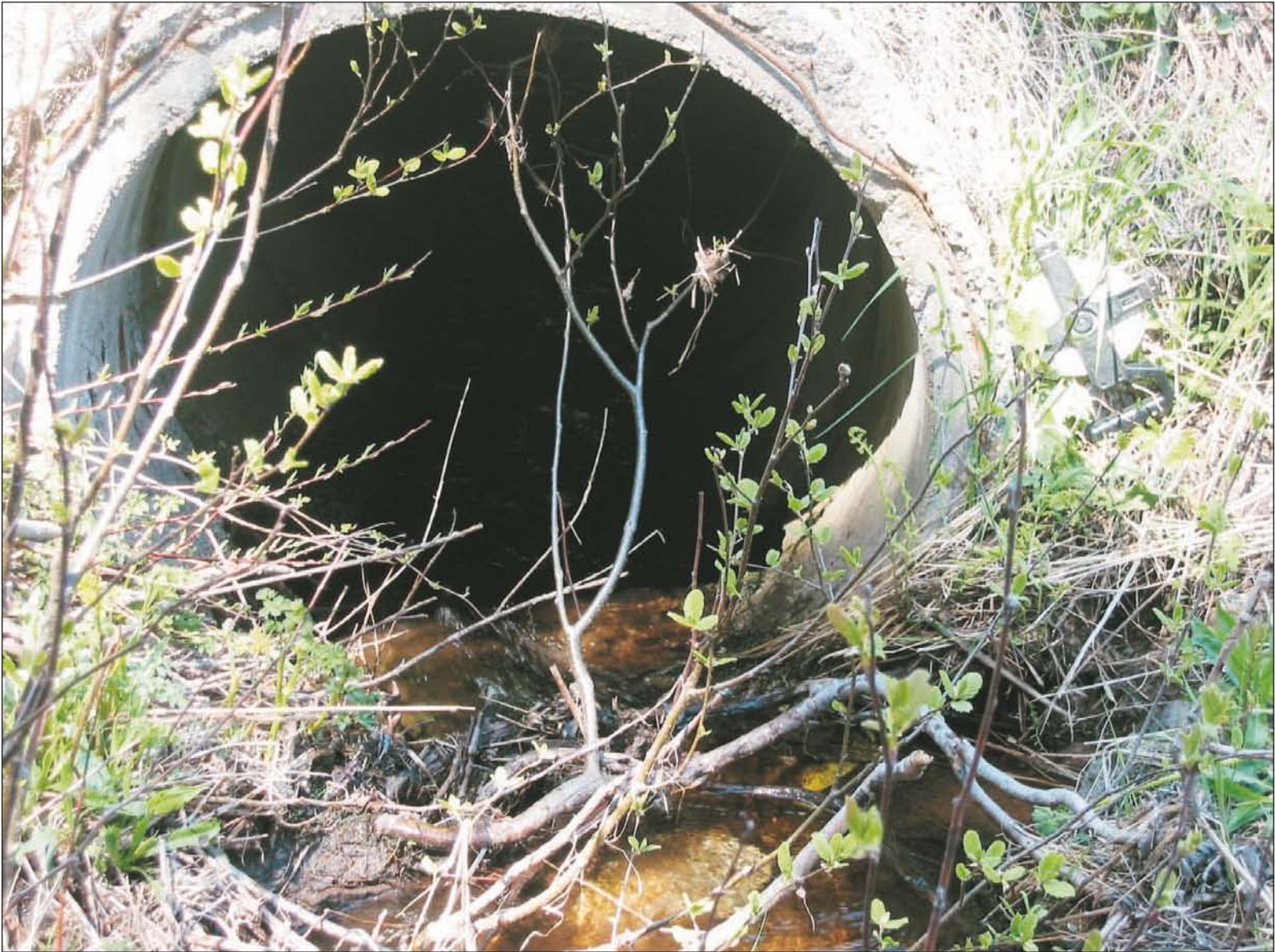
Photo 6 Émissaire en amont de la route 132, 24-05-2006.
