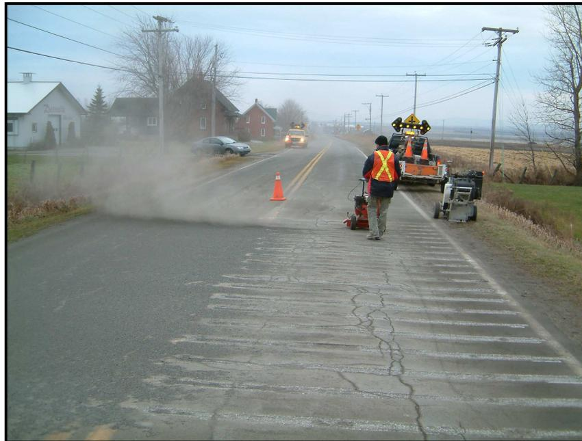
**Figure 60** Bandes d'alertes transversales réalisées par fraisage
