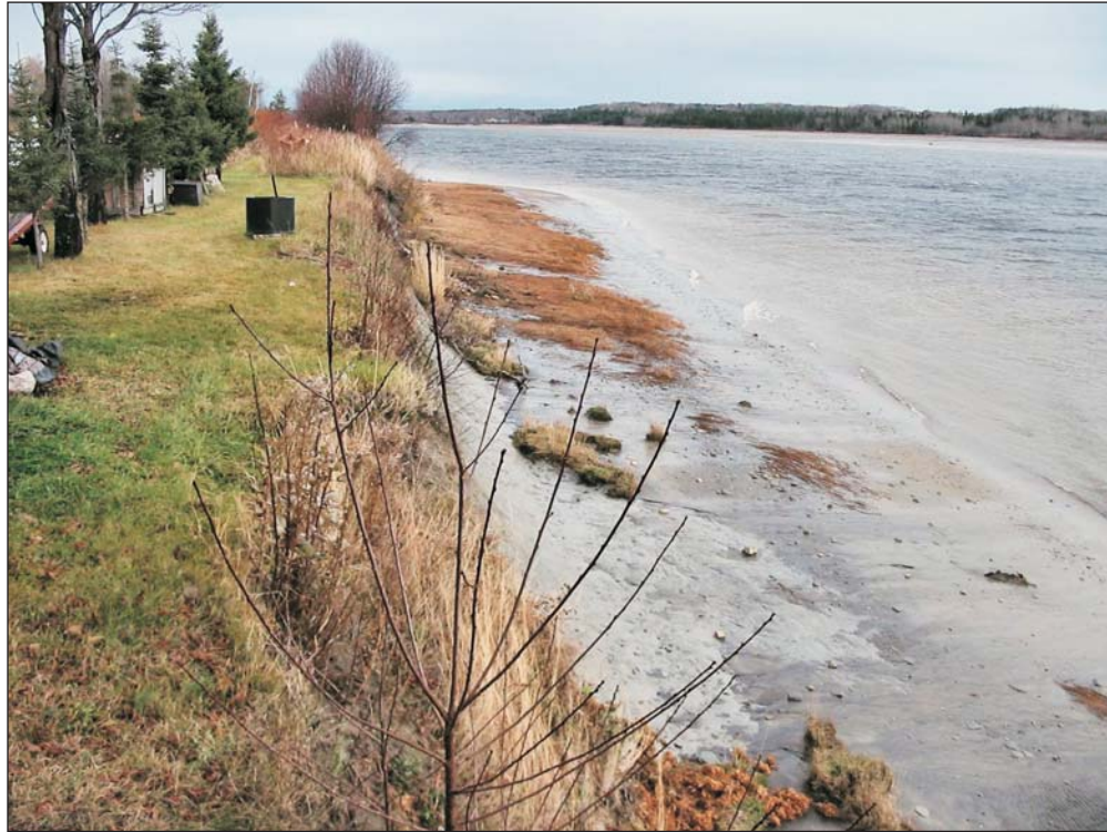
Photo 15. Portion ouest de la falaise située à l'arrière du 197 route 138 (Rag-17)
