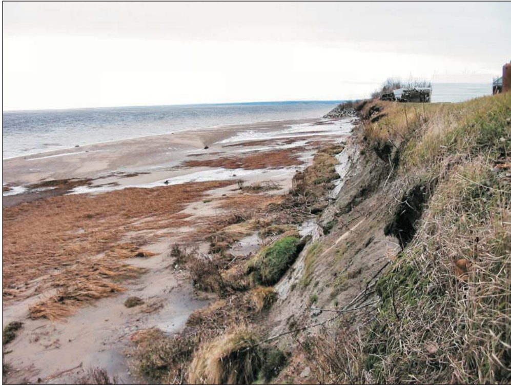
Photo 12. Portion ouest de la falaise située à l'arrière du 335 route 138 (Rag-16)
