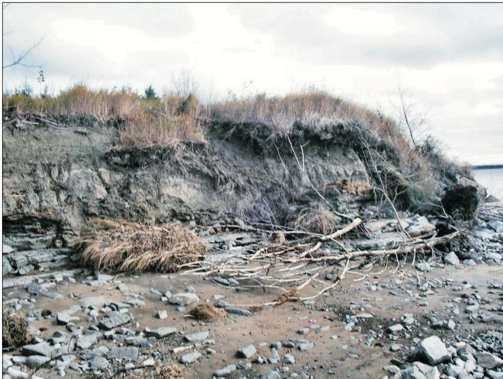
Photo 8. Portion est de la falaise située à l'arrière du 535 route 138 (Rag-14)
