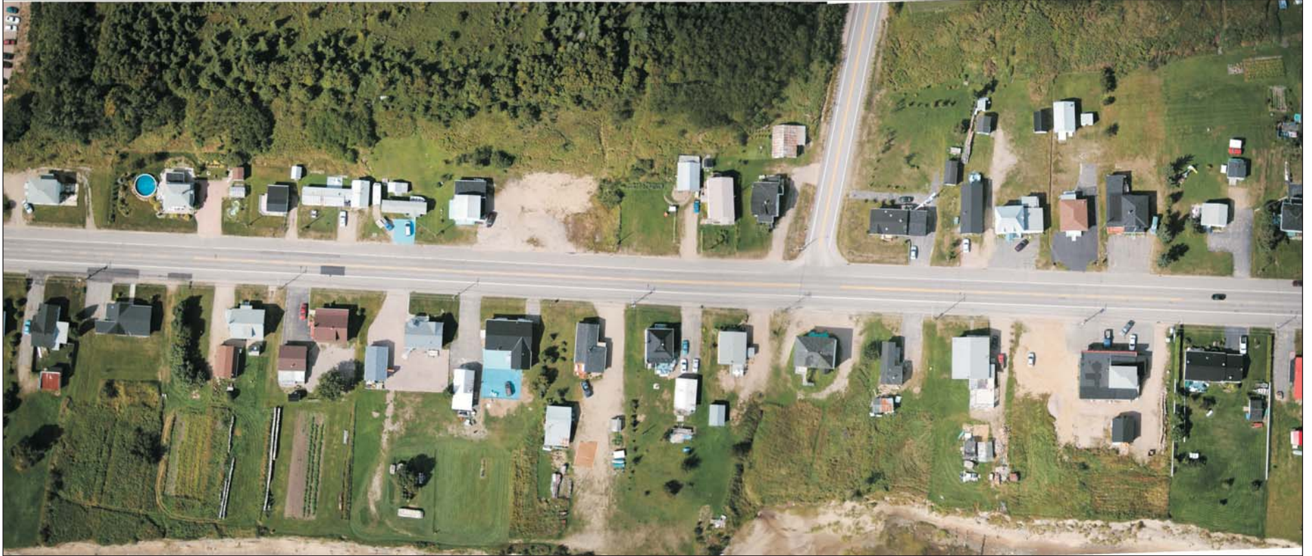
Photo 6. Vue aérienne d'une portion des sections Rag-14 et Rag-15
